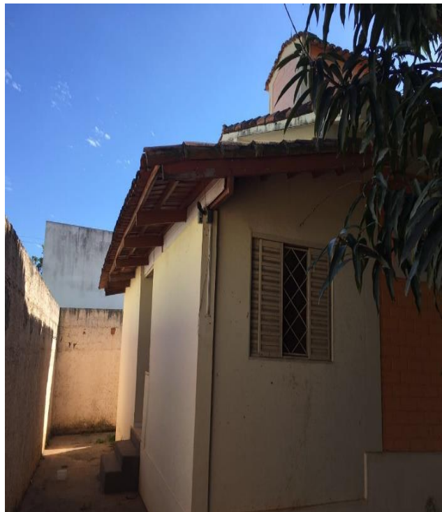
Foto 04: Pintura área externa e troca das telhas.
