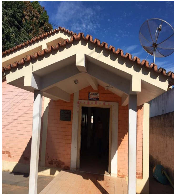
Foto 01: Pintura área externa e troca das telhas.
