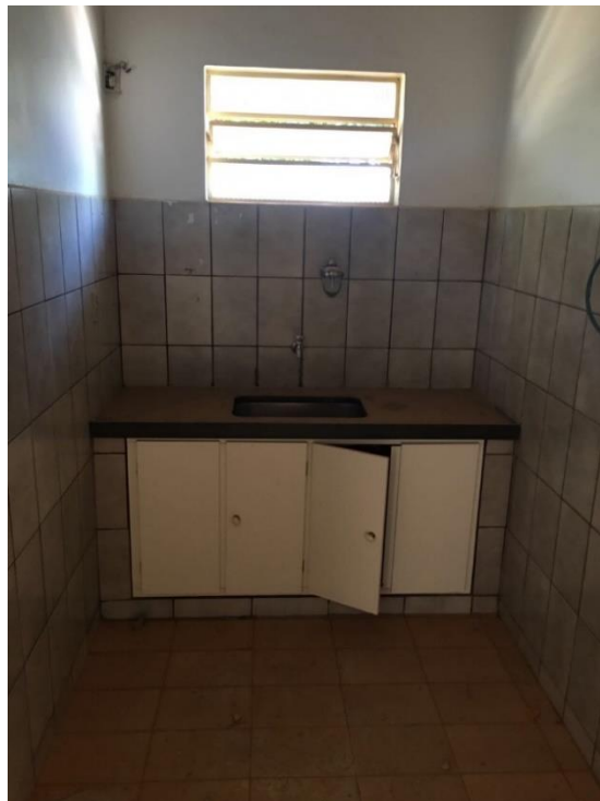
Foto 08: Retirada de janela e porta, demolição de alvenaria e bancada para ampliação do banheiro masculino.
