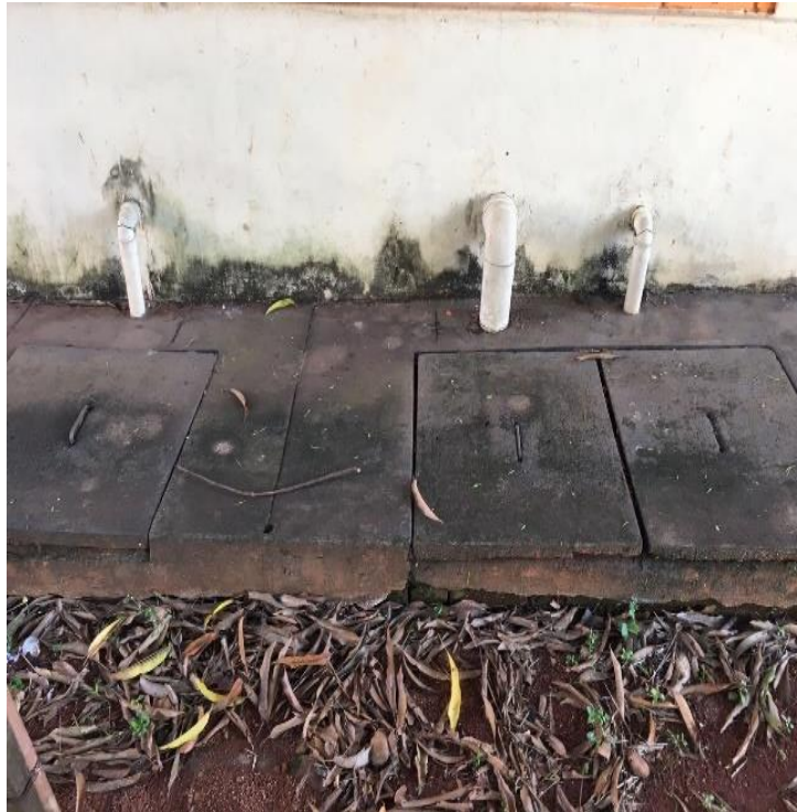
Foto 05: Manutenção nas caixas de passagem e construção de mais uma para tubulação de esgoto.
