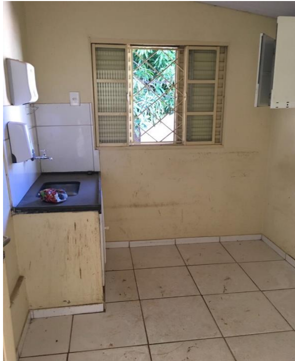
Foto 09: Pintura das paredes e troca de cerâmica.
