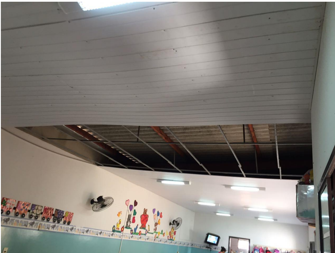
Figura 2 – Forro de PVC do Berçário III
