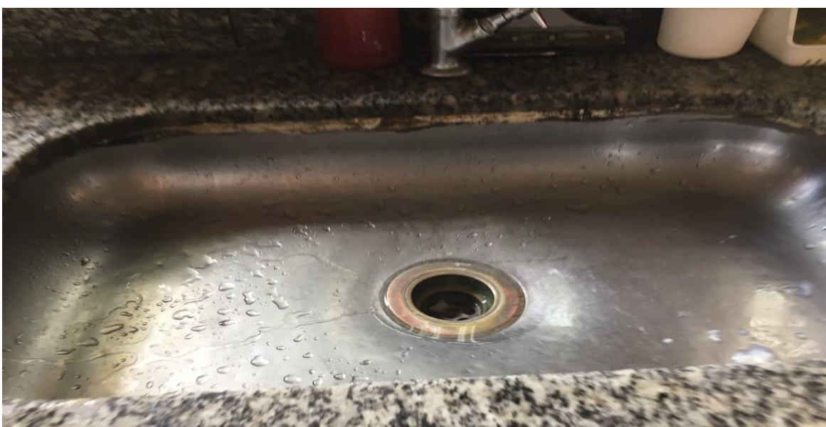
Figura 5 – Reparo realizado na cuba de inox da Cozinha
