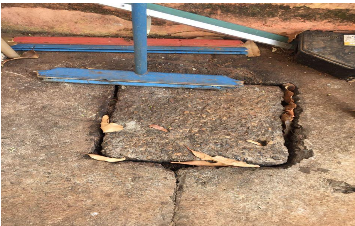
Figura 7 – Troca da caixa de gordura
