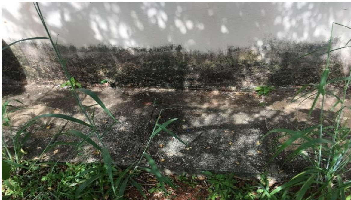
Figura 8 - Manutenção caixa de esgoto
