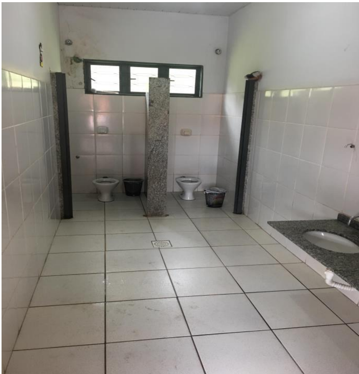
Figura 1 - Reforma do banheiro conforme croqui e memorial descritivo em anexo.
