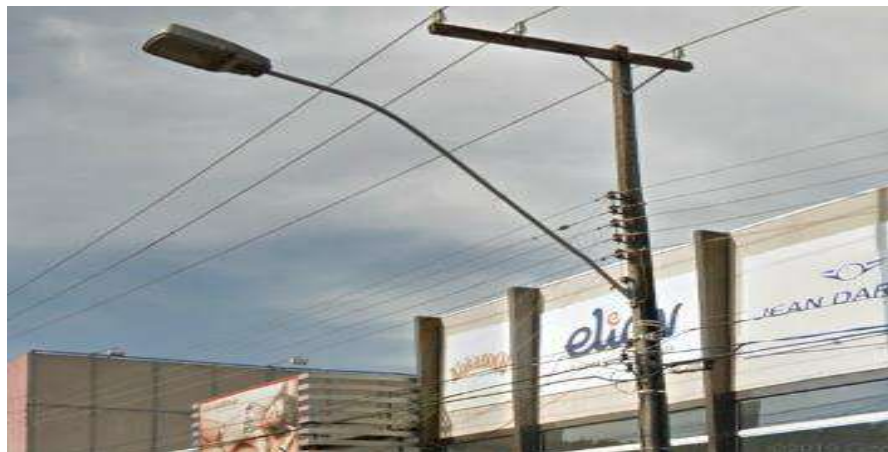
Figura 4 – Braços Convencional de 3 metros (utilizados unilateralmente ou bilateralmente)
