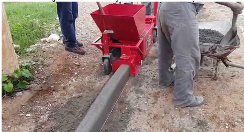
Figura 5 - Modelo de execução meio-fio extrusado sem sarjeta
