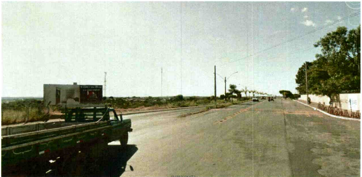
Foto 3: Vista do local do acesso em nível 01 – sentido Catalão-Goiânia
