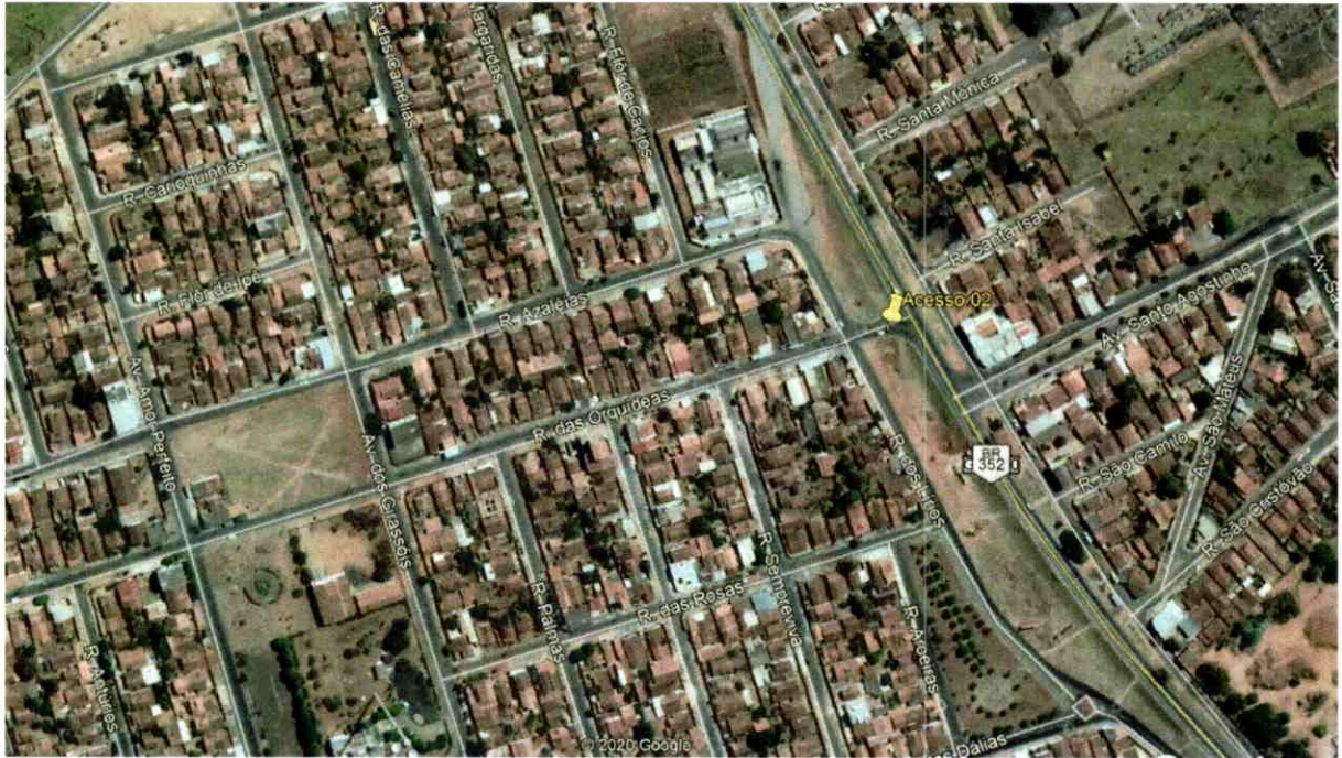
Foto 4: Vista área individualizada do acesso em nível 02
