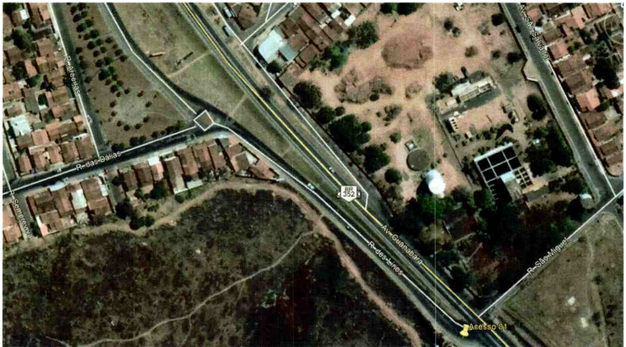
Foto 2: Vista área individualizada do acesso em nível 01
