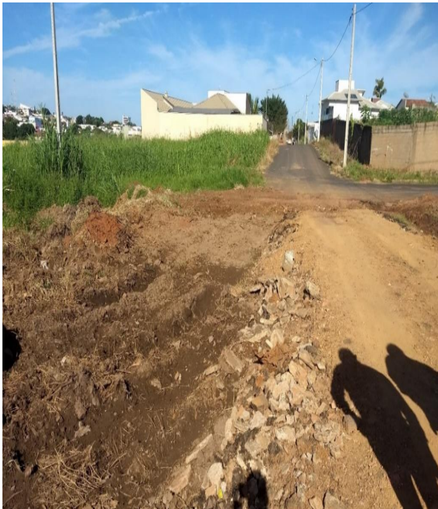
Foto 01 – vias sem dispositivos de drenagem pluvial e com presença de água.
