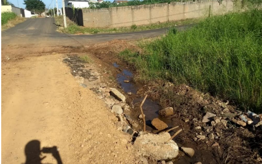
Foto 01 – vias sem dispositivos de drenagem pluvial e com presença de água.
