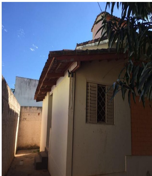
Foto 04: Pintura área externa e troca das telhas.
