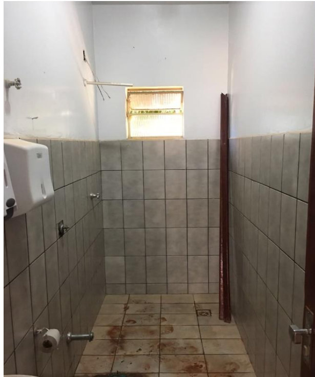
Foto 07: Retirada de janela, demolição de alvenaria, bacia sanitária e lavatório para ampliação do banheiro masculino.
