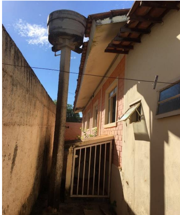
Foto 03: Pintura área externa, troca de caixa d'água e trocas das telhas.
