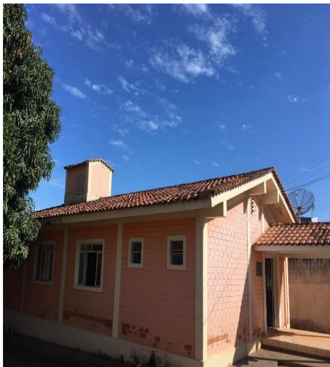
Foto 02: Pintura área externa e troca das telhas.
