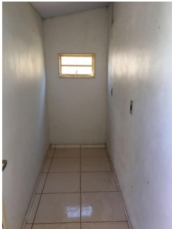
Foto 10: Retirada de janela, demolição de alvenaria para ampliação do banheiro feminino.
