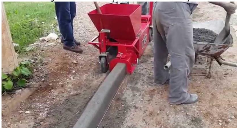
Figura 5 - Modelo de execução meio-fio extrusado sem sarjeta
