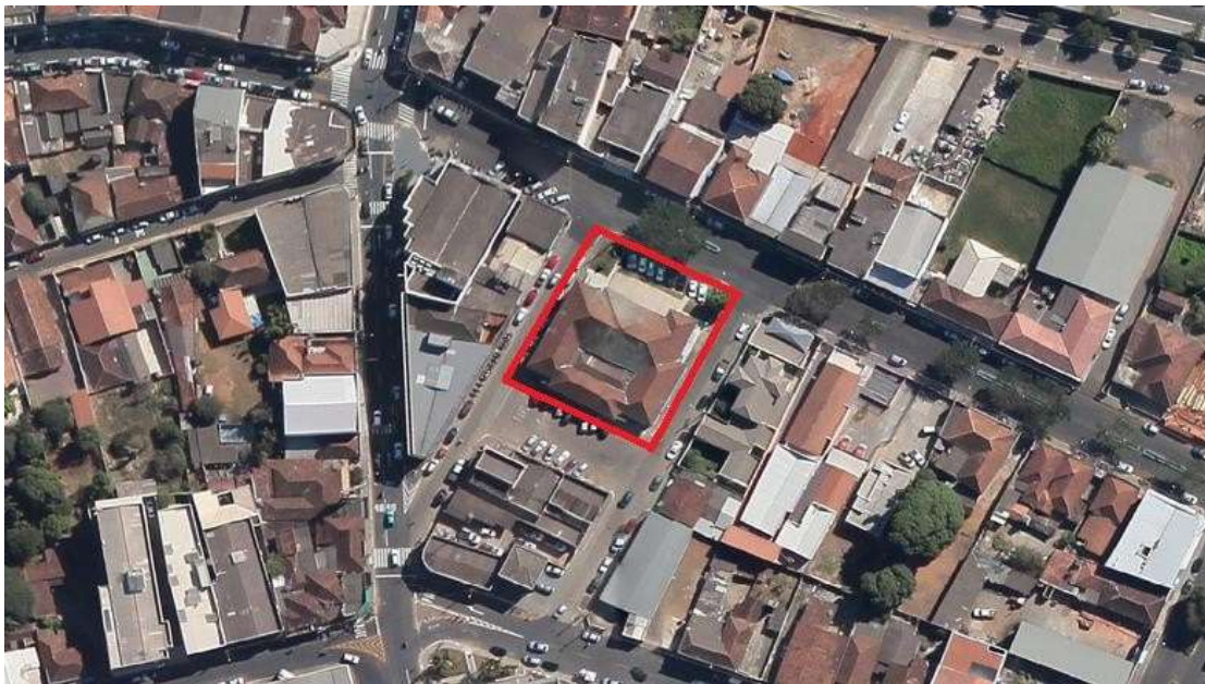
Figura 1 – Localização da obra. (Latitude: 18°10'04.43" S; Longitude: 47°56'37.00" O). Fonte: Google Earth (2020).
