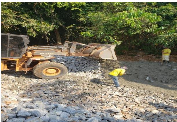
**Imagem 3:** Construção de entrada de água pluvial
