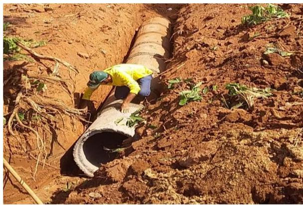
**Imagem 6:** Instalação de manilha em rede pluvial
