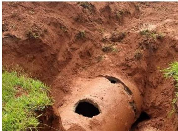
**Imagem 4:** Manilha danificada provavelmente pela força da água
