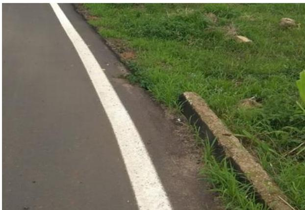
**Imagem 1:** Via com meio-fio inacabado
