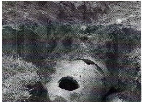
**Imagem 4:** Manilha danificada provavelmente pela força da água
