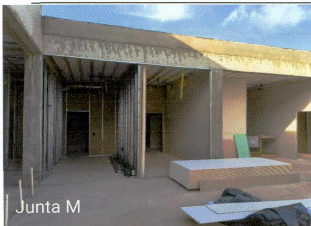
Foto 32 e 35: Montagem do drywall; execução de instalações; montagem da estrutura metálica.
