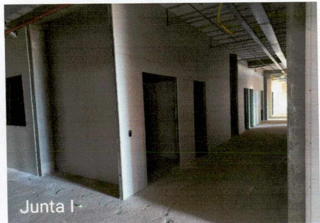
Fotos 19 a 21: Montagem do drywall; execução de instalações; montagem das telhas.
