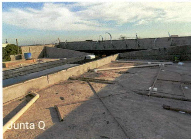
Fotos 44 e 46: Execução de instalações; concretagem e regularização do contrapiso; execução de alvenaria da casa de máquinas; regularização das calhas.
