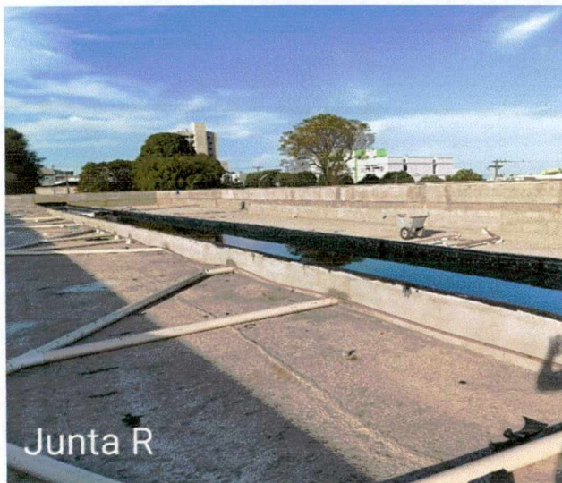
Foto 50 a 51: Execução de instalações; montagem dos contramarcos; impermeabilização das calhas.
