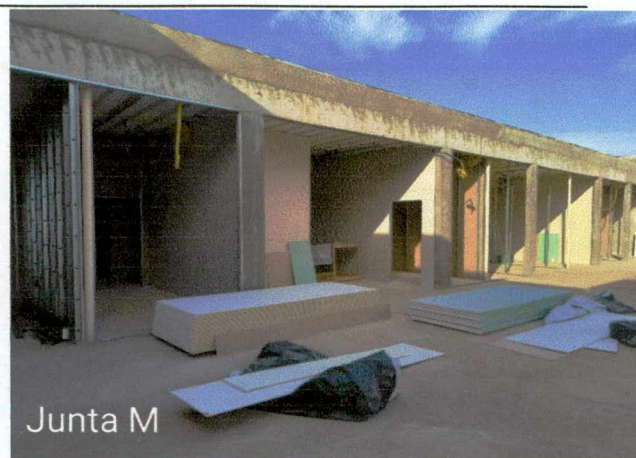
Foto 32 e 35: Montagem do drywall; execução de instalações; montagem da estrutura metálica.
