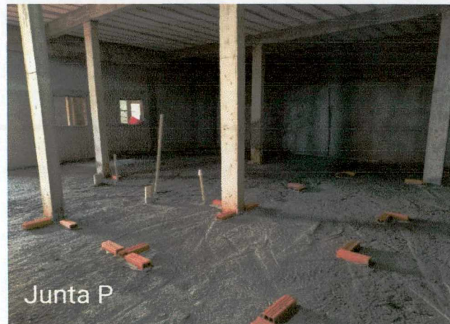
Fotos 44 e 46: Execução de instalações; concretagem e regularização do contrapiso; execução de alvenaria da casa de máquinas; regularização das calhas.
