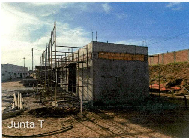
Fotos 55 a 56: Execução de alvenaria; concretagem de vigas e das lajes; execução de chapisco e reboco externo.
