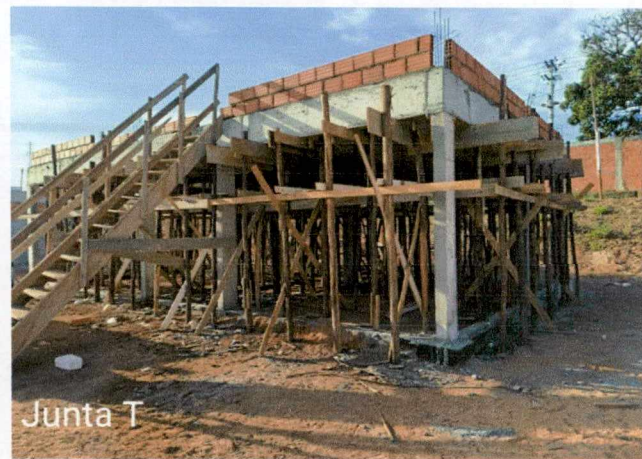
Fotos 55 a 56: Execução de alvenaria; concretagem de vigas e das lajes; execução de chapisco e reboco externo.
