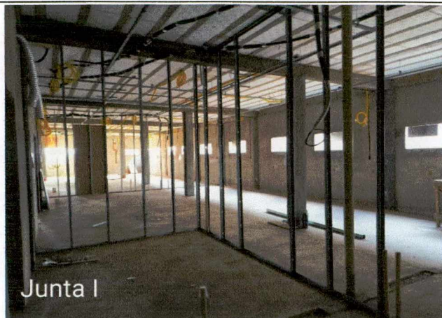
Fotos 22 a 24: Montagem do drywall; execução de instalações; montagem da estrutura metálica; montagem dos contramarcos.
