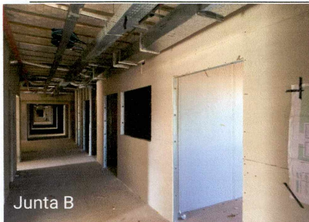
Fotos 4 a 5: Montagem do drywall; execução de instalações; montagem das telhas; preparação para rodapé embutido.
