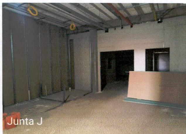
Fotos 25 a 26: Montagem do drywall; execução de instalações; montagem da estrutura metálica.
