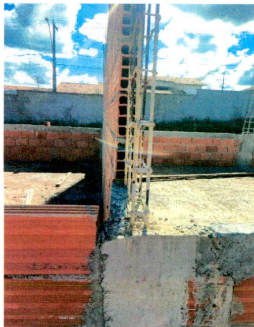
Foto 05: Concretagem de pilar
