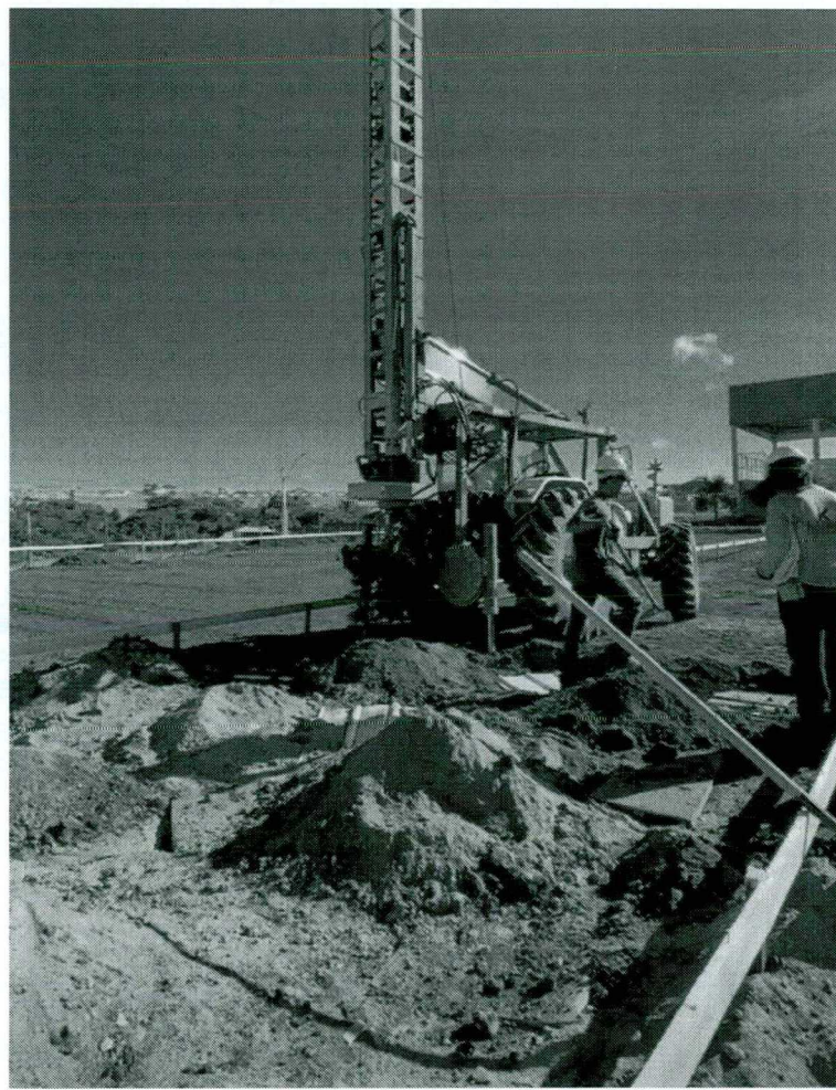
Foto 1: Perfuração para estacas.
