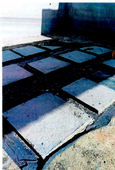
Foto 1: Concretagem das tampas das caixas de passagem.
