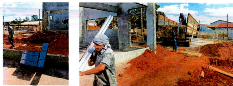
Fotos 4, 5 e 6: Chegada do material para a execução do steel frame.
