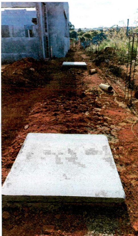
Foto 2: Execução de rede sanitária.
