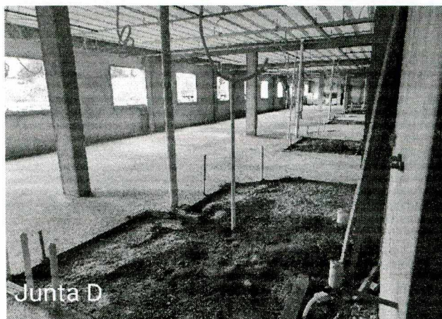
Fotos 13 a 15: Regularização de contrapiso; regularização das calhas;
