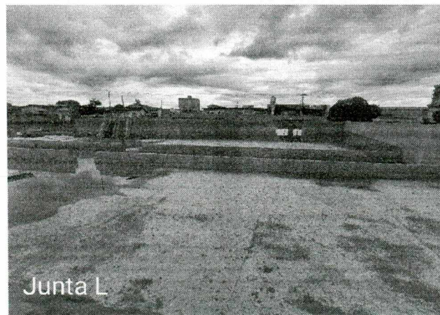
Fotos 37 a 39: Execução de alvenaria da platibanda e da calha; execução de reboco da platibanda;
