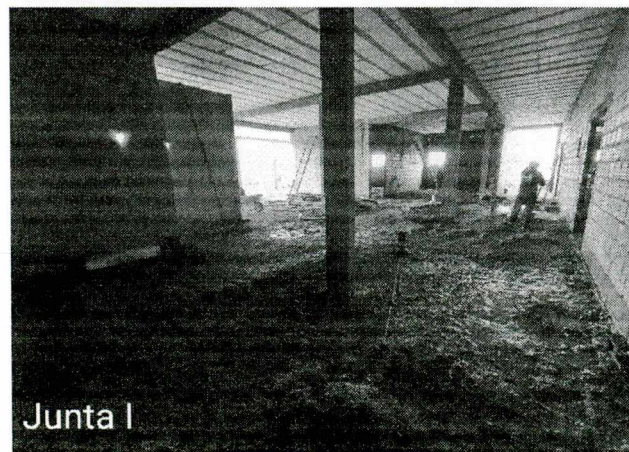
Fotos 28 a 30: Concretagem da laje; execução de alvenaria da platibanda e da casa de máquinas; execução de chapisco e reboco da platibanda; execução de alvenaria da calha;
