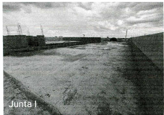
Fotos 25 a 27: Regularização de contrapiso; execução de alvenaria e regularização da calha; execução de instalações pluviais (cobertura);
