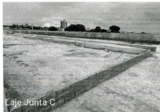
Fotos 5 a 8: Execução de pingadeiras; execução de alvenaria das calhas; regularização das calhas;
