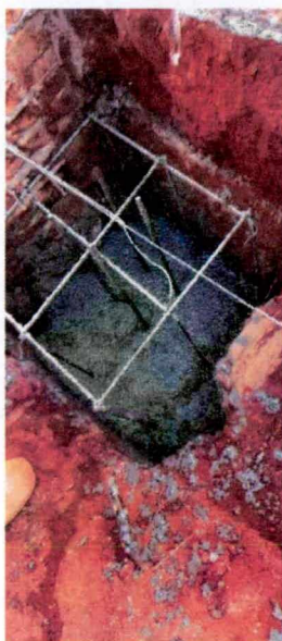
Foto 05: Concretagem de blocos e estacas do aditivo
