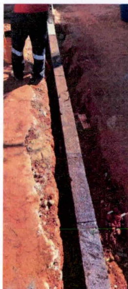
Foto 03: Viga baldrame do aditivo
