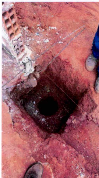
Foto 04: Escavação para as estacas e blocos do aditivo
