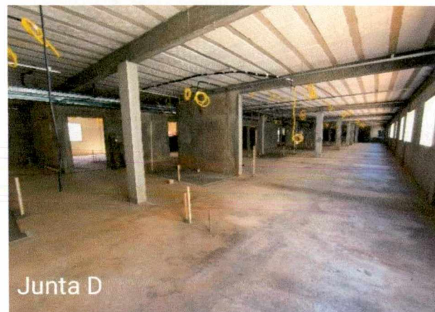
Fotos 13 a 16: Regularização de contrapiso; execução de instalações (climatização, gases medicinais).
