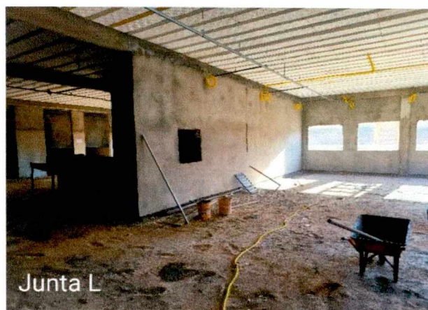
Fotos 37 a 38: Execução de chapisco e reboco interno; execução de instalações (elétrica e incêndio).
