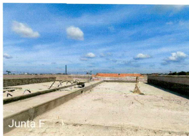
Fotos 17 a 19: Regularização de contrapiso; execução de instalações (incêndio e climatização).
