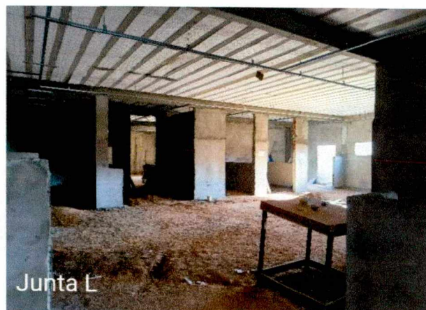
Fotos 37 a 38: Execução de chapisco e reboco interno; execução de instalações (elétrica e incêndio).
