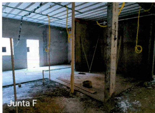
Fotos 17 a 19: Regularização de contrapiso; execução de instalações (incêndio e climatização).
