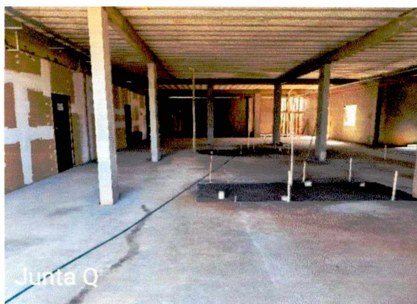
Fotos 42 e 43: Regularização de contrapiso; execução de instalações elétricas; execução de alvenaria da calha.
