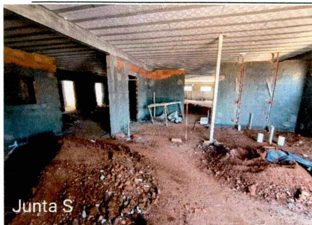
Fotos 46 e 47: Montagem das vigas de cobertura e da laje; concretagem da laje; execução de chapisco e reboco interno; execução de instalações (hidrossanitário).
