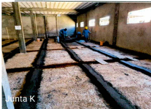
Fotos 33 a 36: Execução de reboco interno; execução de instalações pluviais; regularização de contrapiso.
