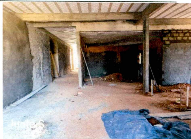
Fotos 46 e 47: Montagem das vigas de cobertura e da laje; concretagem da laje; execução de chapisco e reboco interno; execução de instalações (hidrossanitário).
