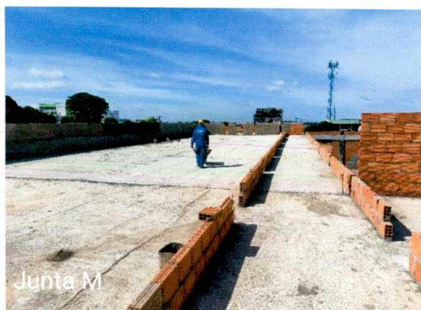
Foto 39: Respaldo de alvenaria; montagem das vigas de cobertura e da laje; concretagem da laje; execução da alvenaria da platibanda, da casa de máquinas e da calha.
