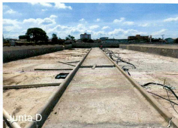
Fotos 13 a 16: Regularização de contrapiso; execução de instalações (climatização, gases medicinais).
