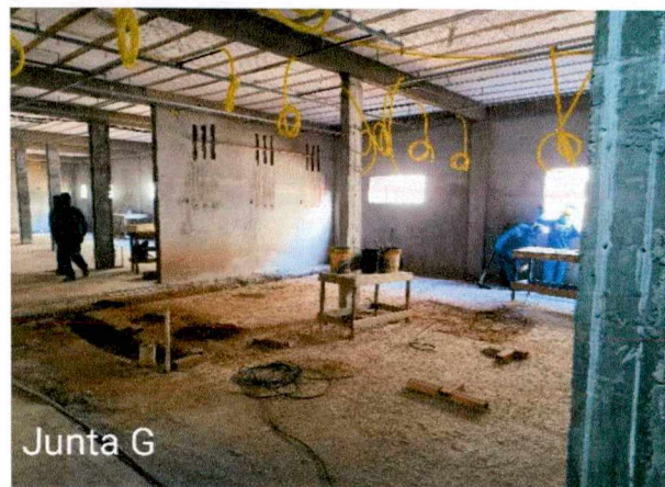
Fotos 22 a 24: Regularização de contrapiso; execução de instalações (gases medicinais e incêndio).
