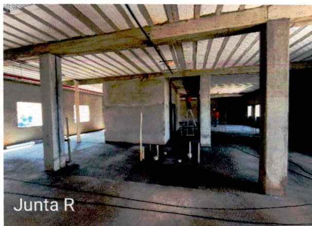
Fotos 44 e 45: Regularização de contrapiso; infra de instalações elétricas; requadro de portas, janelas e pilares; execução de reboco interno.
