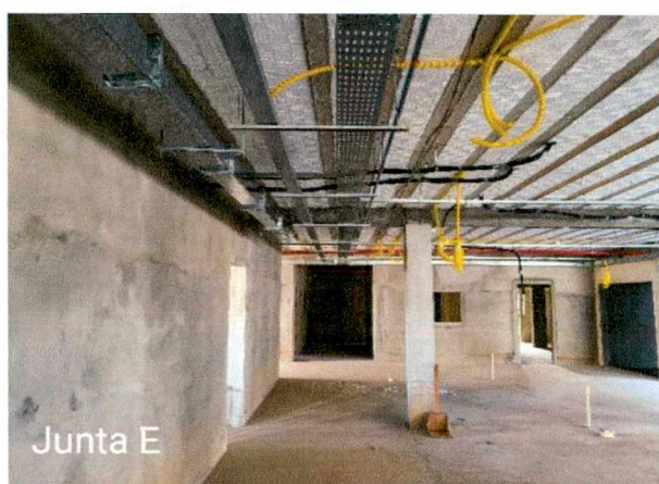
Fotos 17 a 19: Regularização de contrapiso; execução de instalações (incêndio e climatização).
