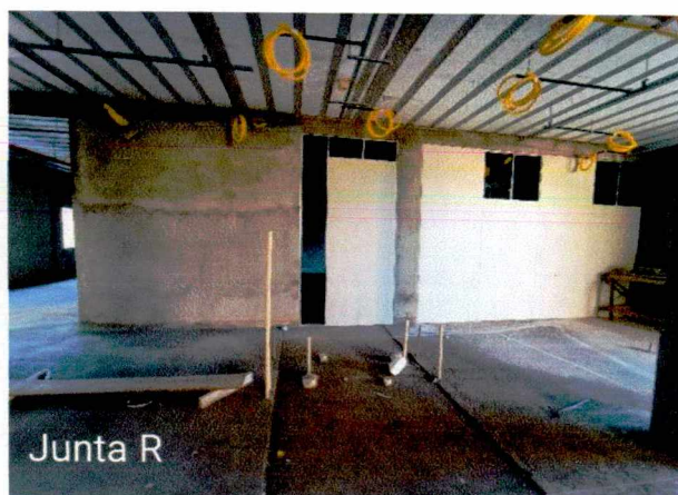
Fotos 44 e 45: Regularização de contrapiso; infra de instalações elétricas; requadro de portas, janelas e pilares; execução de reboco interno.
