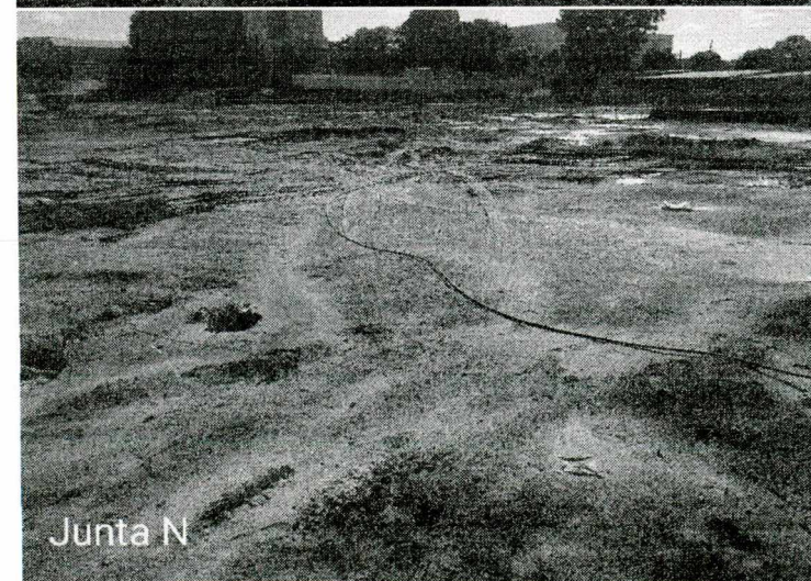
Fotos 16 a 18 – Baldrame impermeabilizada e marcação de alvenaria (L), escavação de baldrame (M) e estacas concretadas (M, N)
