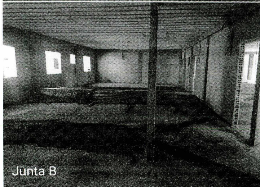
Fotos 05 e 06 – Reboco Interno, Contrapiso (exceto banheiros)
