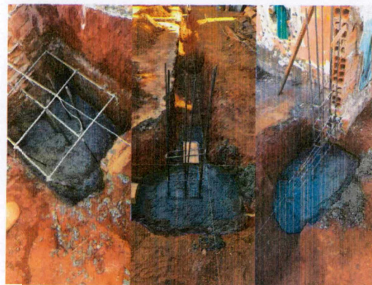
Foto 05: Armação de estacas, blocos e concretagem
