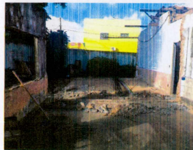
Foto 02: Demolição de paredes antigas
