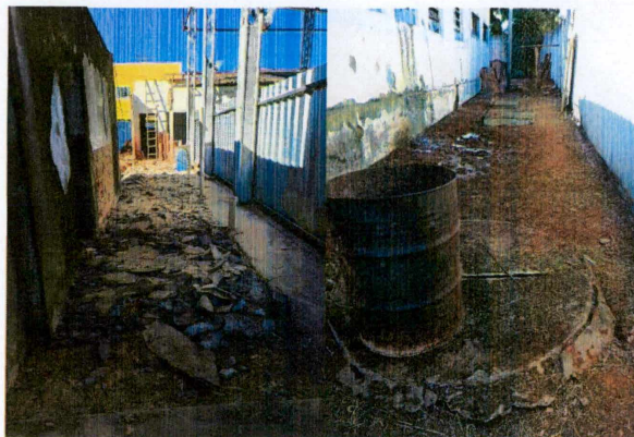
Foto 03: Demolição de revestimento de concreto antigo (salas, corredores e calçadas)
