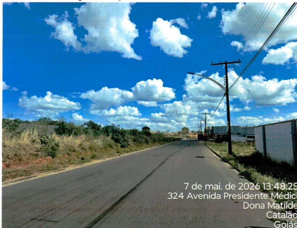
Imagem 08: Situação atual da Rodovia Sebastião de Pádua
