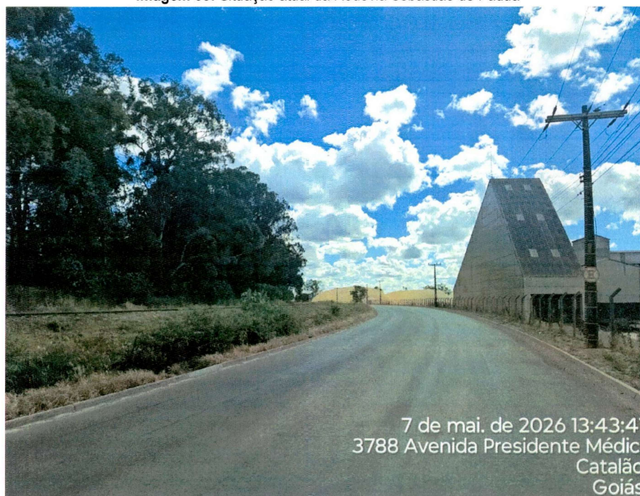
Imagem 03: Situação atual da Rodovia Sebastião de Pádua
