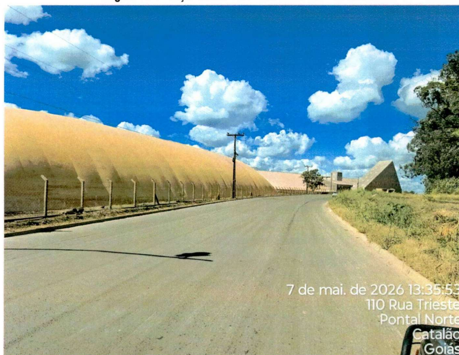
Imagem 01: Situação atual da Rodovia Sebastião de Pádua
