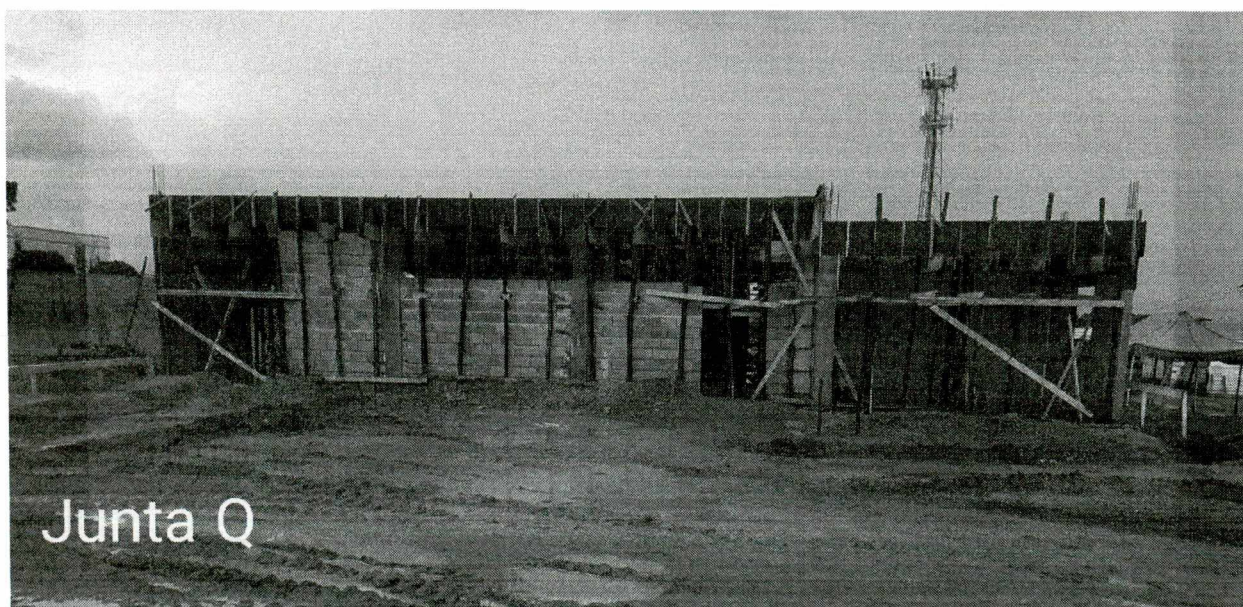
Foto 20 – Montagem das vigas de cobertura, montagem de escoramento e montagem da laje protendida
