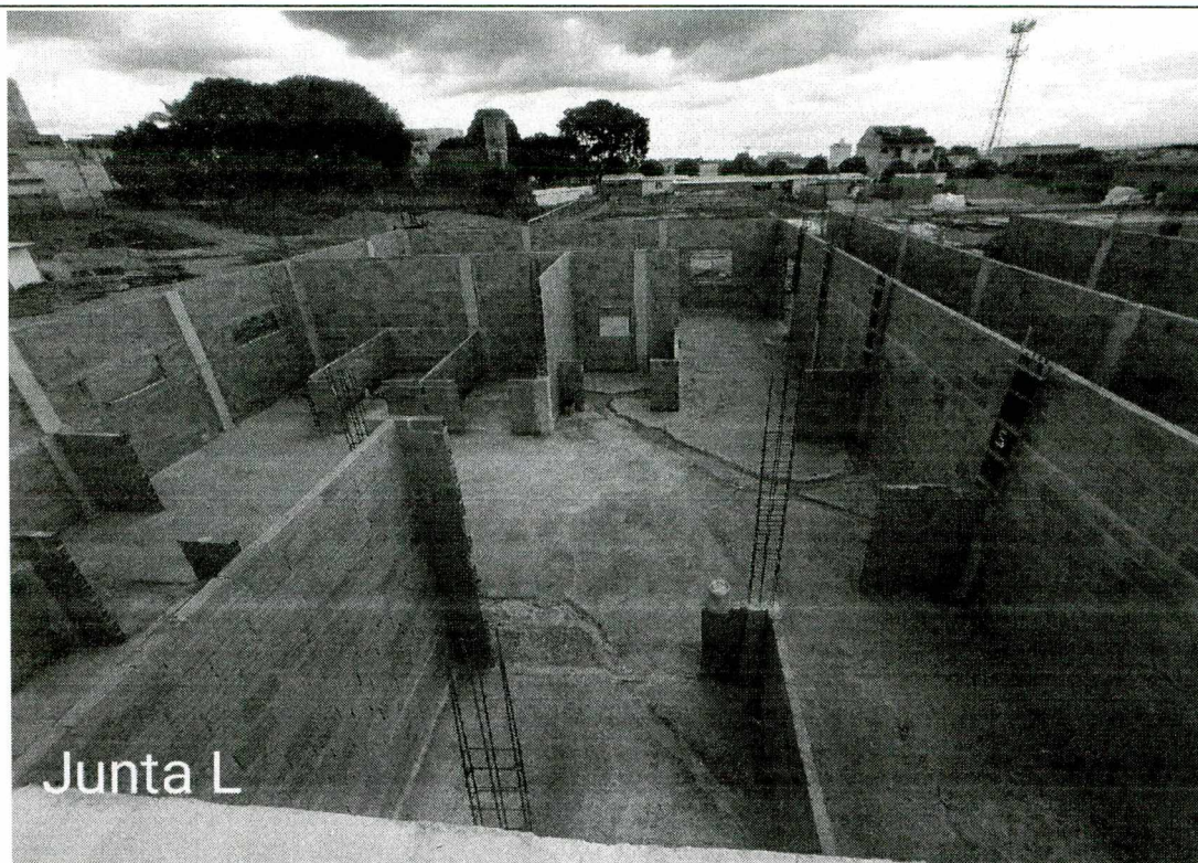
Fotos 15 a 19 – Alvenaria respaldada (L, K), Alvenaria de 1° etapa (I e J), nivelamento e compactação, contrapiso (K e L), concretagem de pilares
