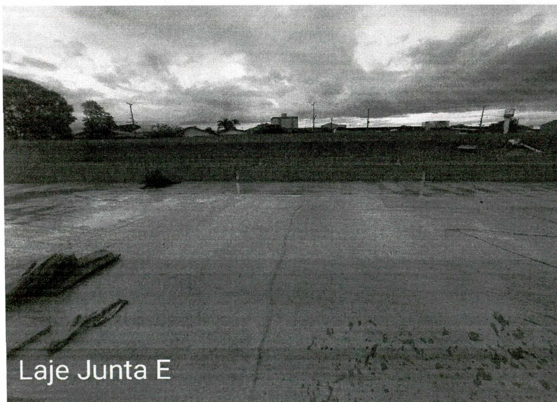
Fotos 10 a 12 – Execução de reboco interno e calha de concreto na laje E
