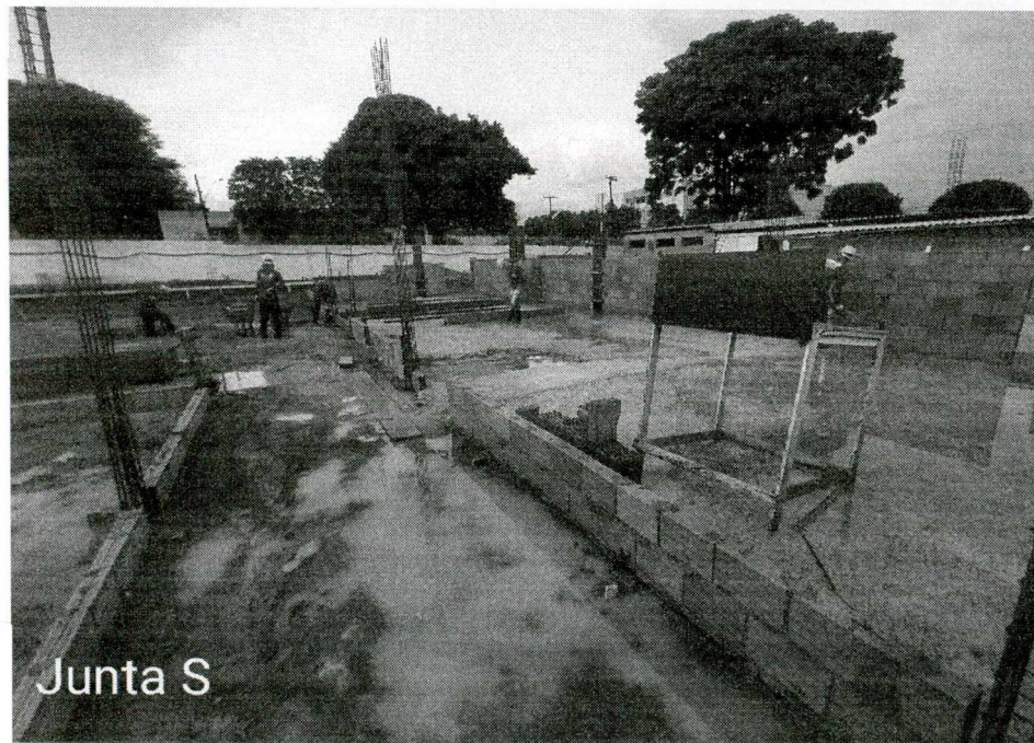
Fotos 25 e 26 – Execução de alvenaria, montagem de pilares, concretagem de pilares (R), concretagem de contrapiso
