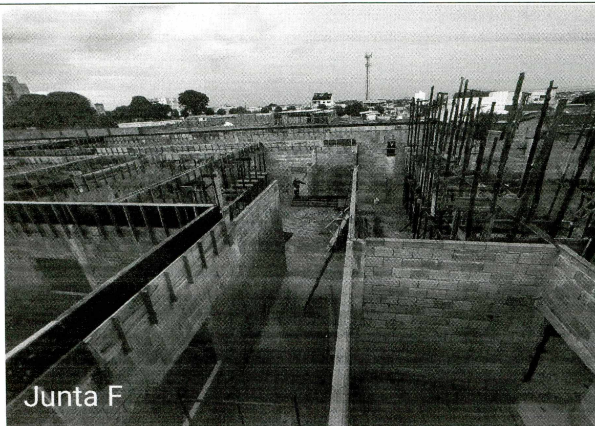
Foto 13 – Montagem das vigas de cobertura, montagem do escoramento
