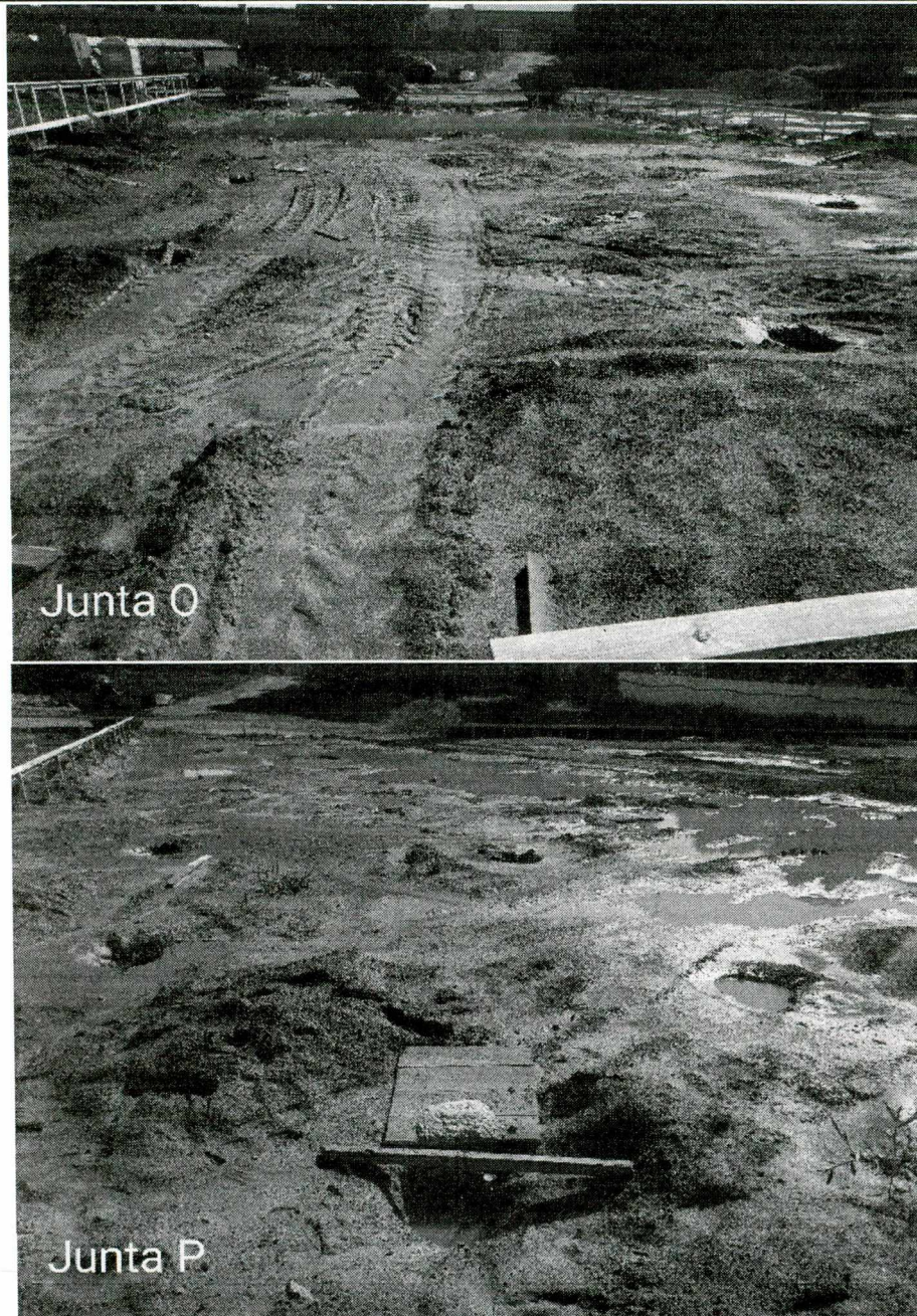
Fotos 21 a 24 – Escavação de baldrame (M) e estacas concretadas (M, N, O e P)
