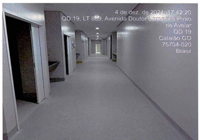
Fotos 10 a 13: Execução de piso vinílico, execução de pintura, instalação de tanques de escovação; instalação de luminárias.
