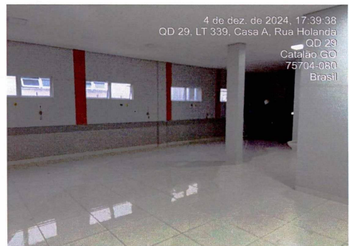
Fotos 14 a 17: Instalação de luminárias, execução de pintura, instalação de bate macas.
