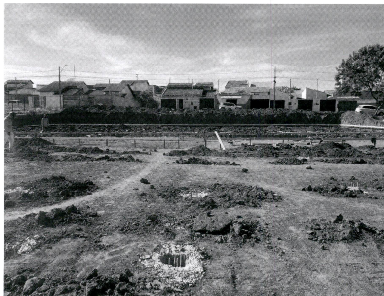
Foto 4: Concretagem fundação estaca
