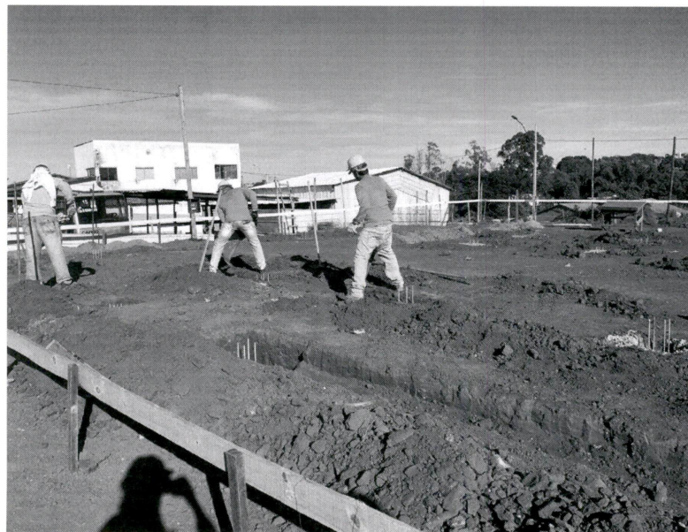
Foto 3: Realizando escavação fundação estaca
