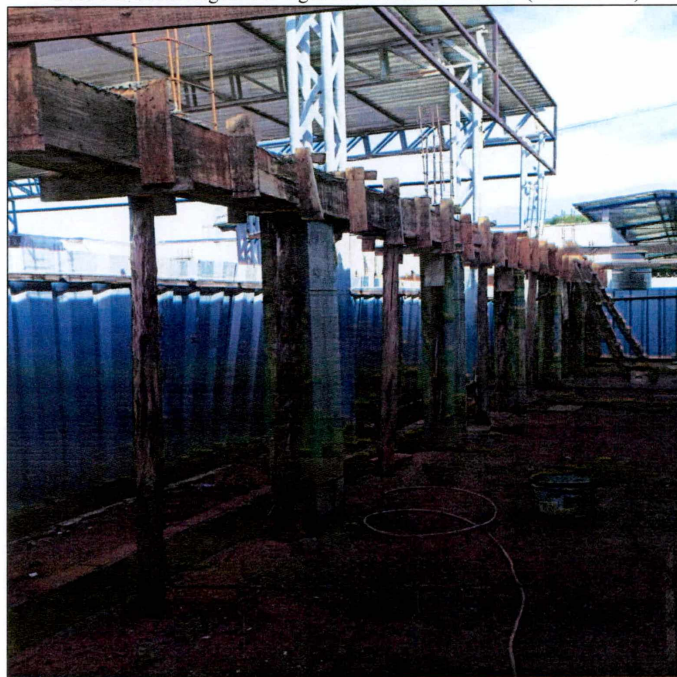
Foto 04: Concretagem das vigas da estrutura do telhado (Corredor 02)
