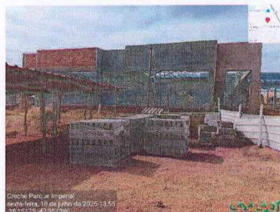
Fotos 01: Blocos de concreto para execução do Muro de Arrimo
