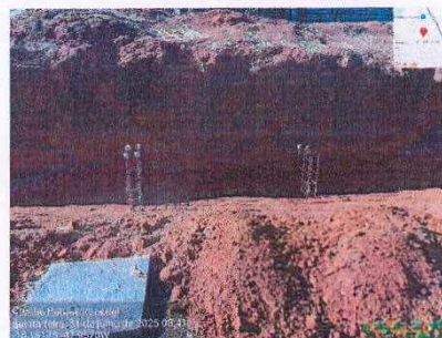
Foto 04: Armação em espera para pilares do Muro de arrimo
