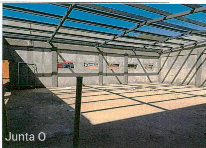
Fotos 40 a 41: Montagem da estrutura metálica; execução de instalações;
