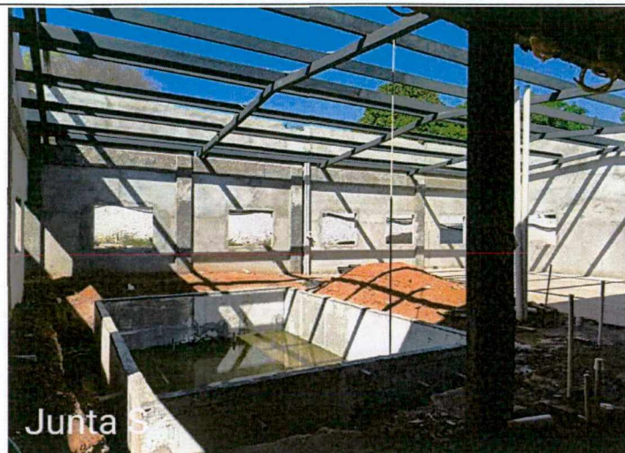
Fotos 50 a 52: Montagem da estrutura metálica; montagem das telhas; montagem do drywall; execução de instalações;
