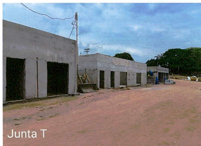
Foto 53: Execução de alvenaria; execução de reboco interno e externo;
