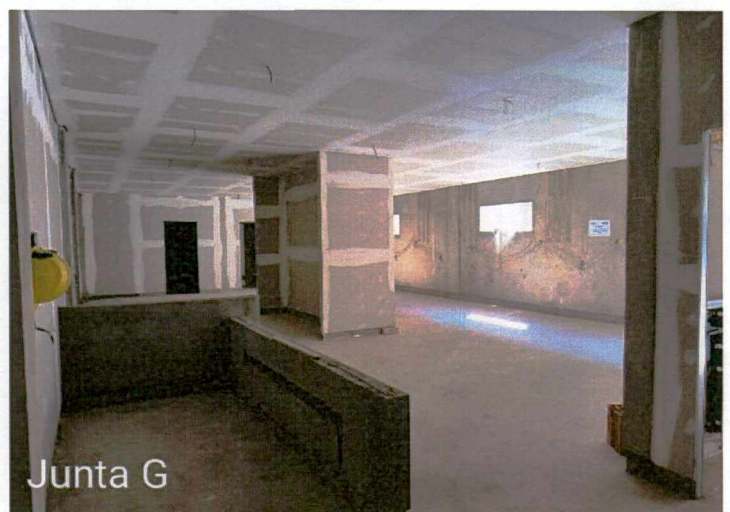
Fotos 21 a 22: Montagem do forro; execução de instalações; preparação para execução de revestimento cerâmico;
