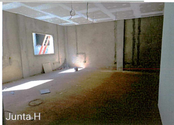
Fotos 23 a 24: Montagem do forro; execução de instalações; preparação para execução de revestimento cerâmico;
