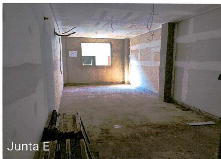
Fotos 11 a 13: Montagem do forro; preparação para execução de revestimento cerâmico;
