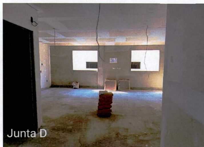
Fotos 9 a 10: Montagem do forro; preparação para execução de revestimento cerâmico;
