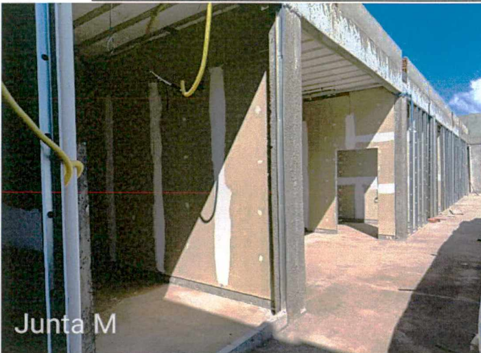
Fotos 34 a 35: Montagem do drywall; montagem do forro; execução de instalações;
