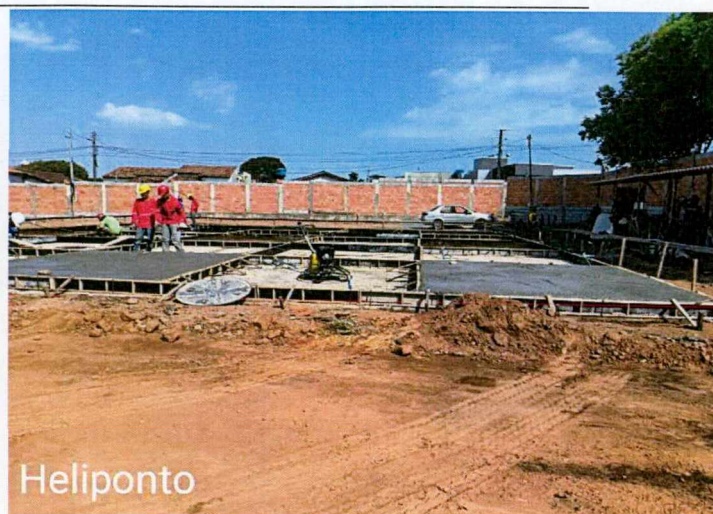
Fotos 56 a 57: Concretagem do lastro do radier; concretagem do radier do heliponto.
