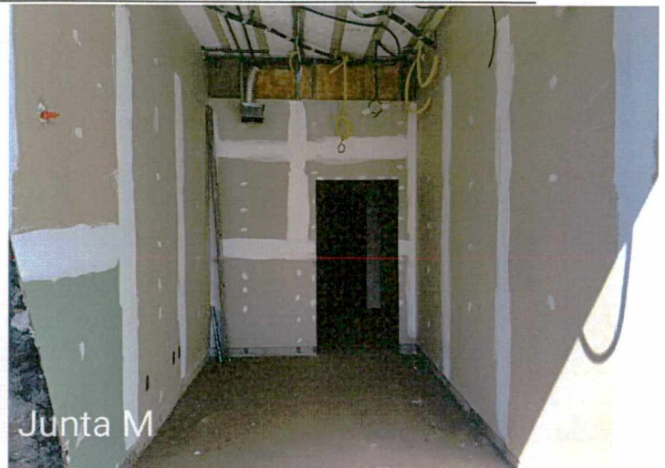
Fotos 34 a 35: Montagem do drywall; montagem do forro; execução de instalações;
