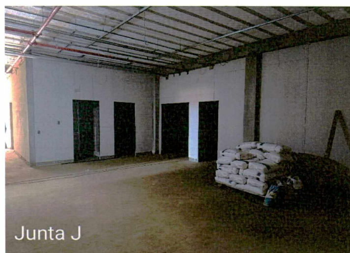
Fotos 27 a 28: Gradeamento do forro; montagem do drywall; execução de instalações; montagem das telhas;
