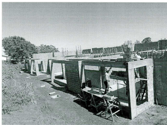
Foto 1: Execução de chapisco na alvenaria
