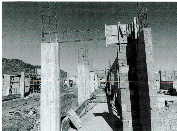
Foto 2: Execução de formas das vigas
