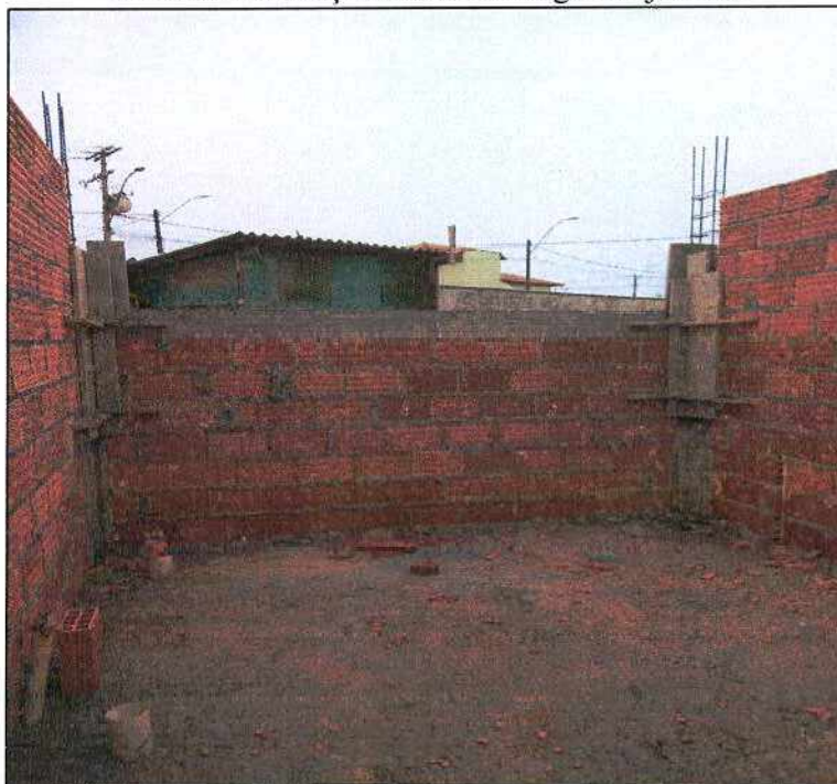
Foto 03: Execução de contraverga das janelas
