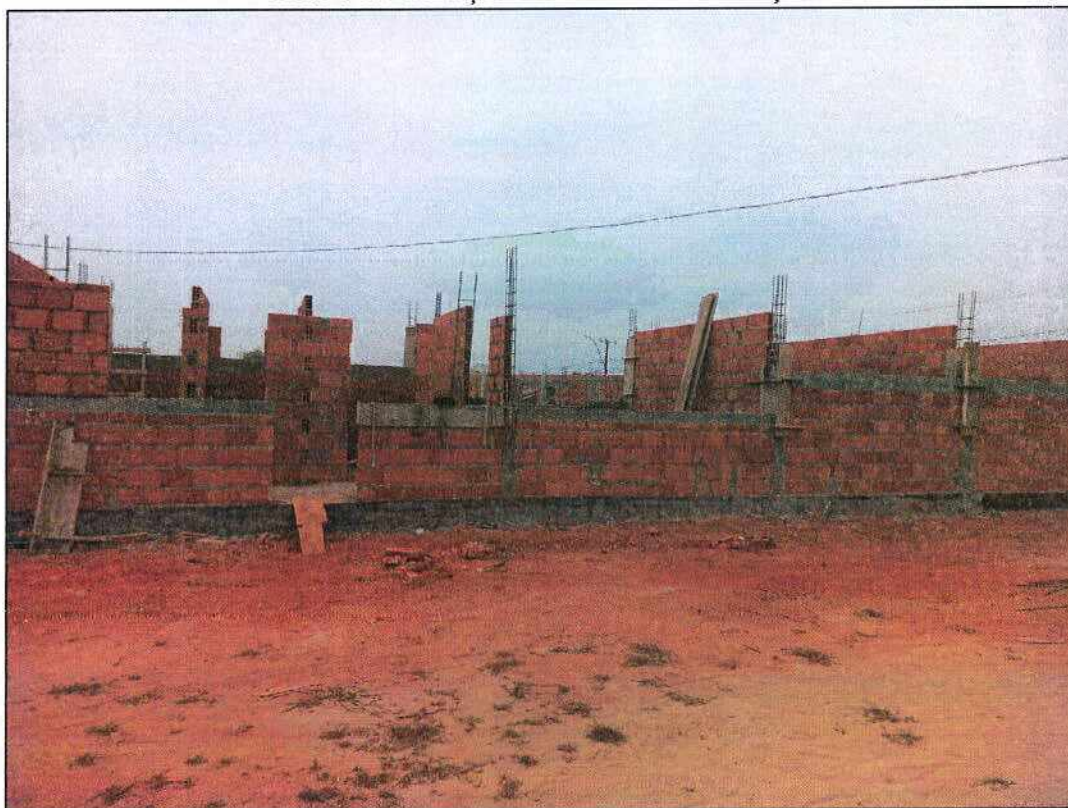
Foto 04: Execução de alvenaria de vedação
