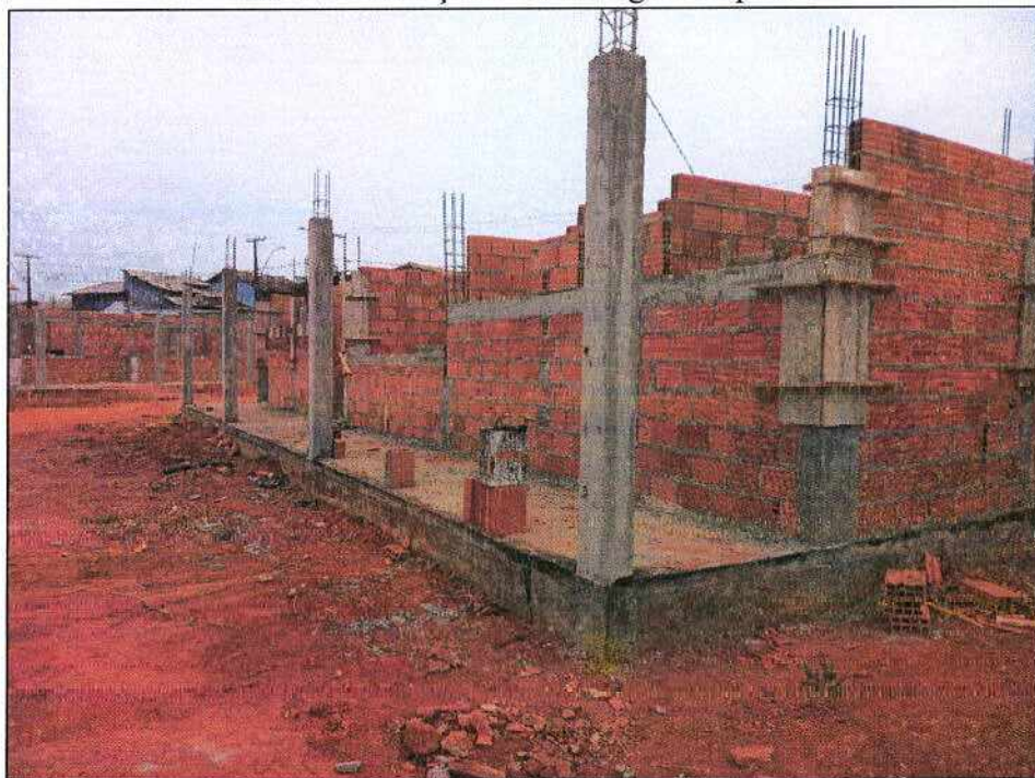
Foto 01: Execução e concretagem de pilares
