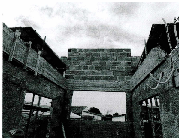
Foto 5: Execução de vigas.
