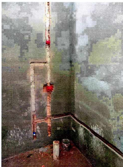
Foto 1: Instalação de Registro.
