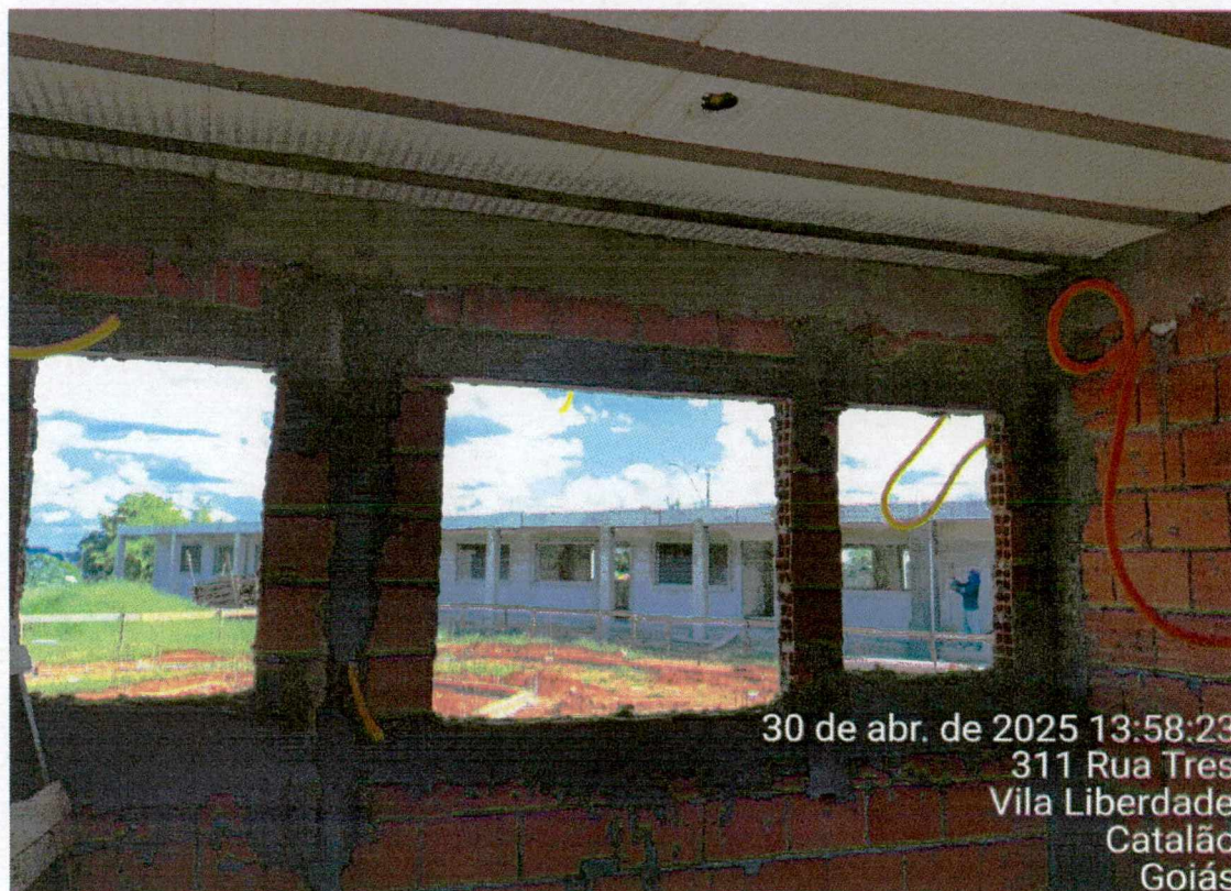
Fotos 03, 04 e 05: Eletrodutos instalados.
