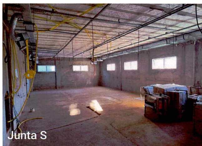
Fotos 23 a 24: Execução de instalações elétricas;
