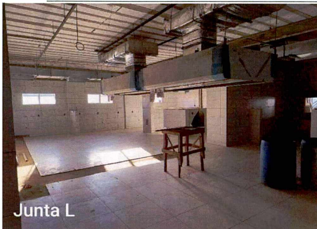
Fotos 15 a 16: Execução de revestimento cerâmico; execução do sistema de ventilação e exaustão da cozinha;
