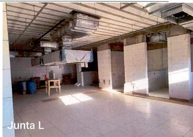
Fotos 15 a 16: Execução de revestimento cerâmico; execução do sistema de ventilação e exaustão da cozinha;
