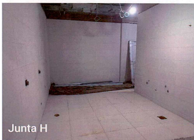
Fotos: 12 a 14: Execução de revestimento cerâmico; execução de instalações elétricas;
