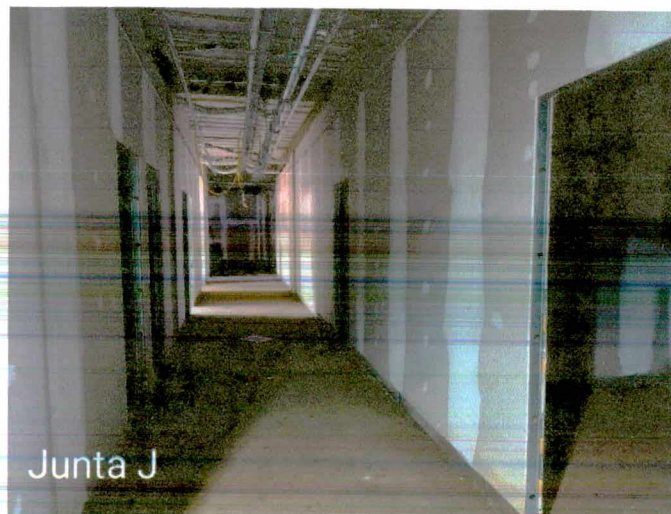
Fotos 33 a 35: Montagem do forro; 1° e 2° demão de maseamento de paredes e teto; execução de instalações elétricas;
