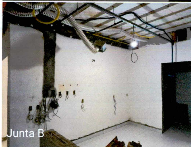
Fotos 4 a 8: Execução de revestimento cerâmico; 1º e 2º demão de masseamento de paredes e teto; execução de instalações de esgoto e pluvial externo; execução de instalações elétricas;
