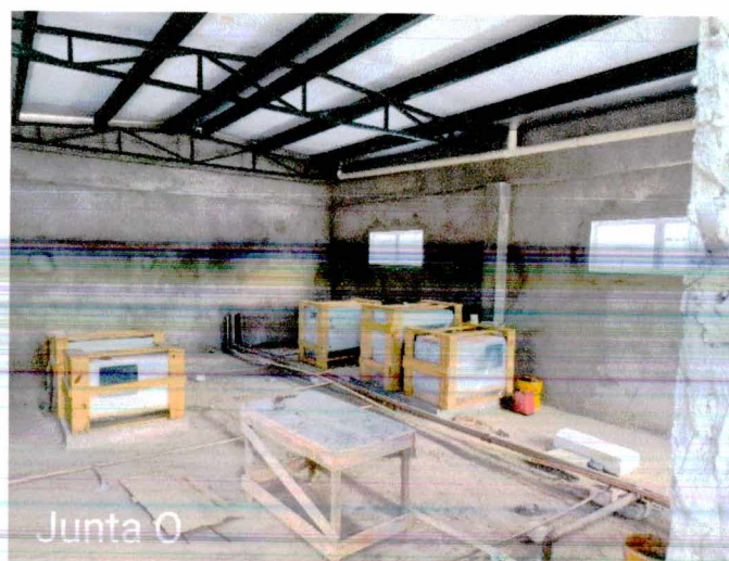
Fotos 49 a 51: 1º e 2º demão de masseamento de paredes; execução de instalações elétricas; montagem dos equipamentos de ar condicionado;
