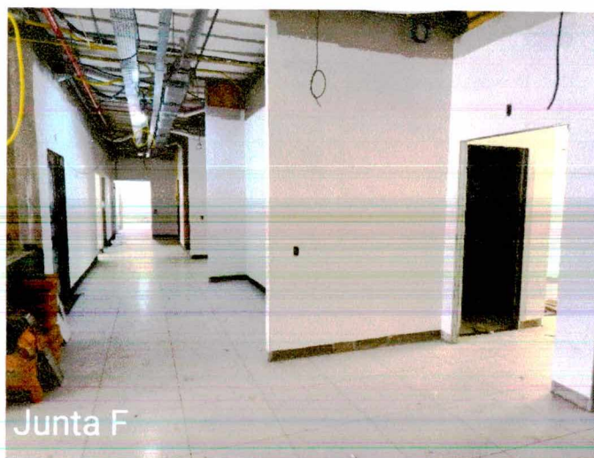
Fotos 20 a 22: Execução de revestimento cerâmico; 1º e 2º demão de masseamento de paredes e teto; execução de instalações elétricas;
