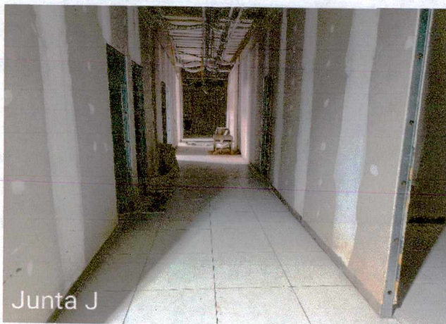
Fotos 19 a 20: Execução de revestimento cerâmico; 1º e 2º demão de maseamento de paredes e teto; execução de instalações elétricas;
