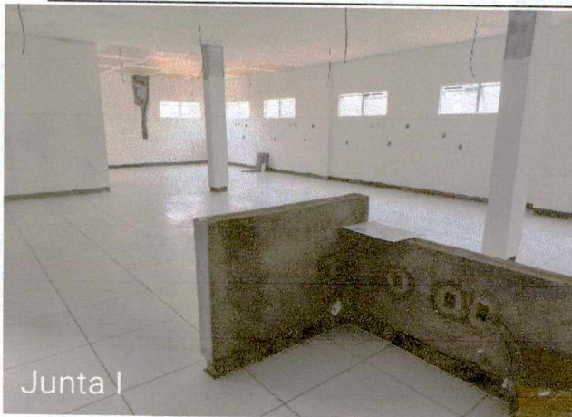
Fotos 17 a 18: Execução de instalações elétricas; execução de revestimento cerâmico; 1º e 2º demão de masseamento de paredes e teto;
