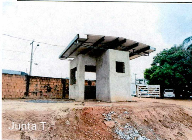
Fotos 39 a 40: Montagem das telhas;
