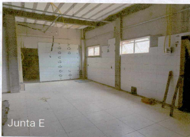
Fotos: 9 a 10: Execução de revestimento cerâmico; 1° e 2° demão de masseamento de paredes e teto; execução de instalações de esgoto e pluvial externo; execução de instalações elétricas; instalação de equipamentos de ar condicionado; instalação de esquadrias;
