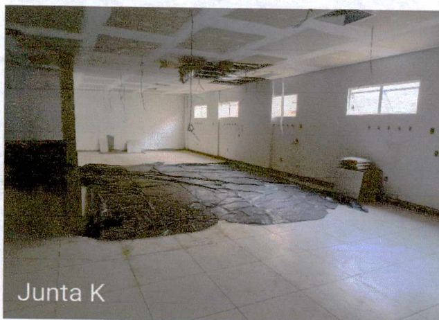
Fotos 21 a 22: Montagem do forro; 1º e 2º demão de masseamento de paredes e teto; execução de instalações elétricas; execução do revestimento cerâmico;
