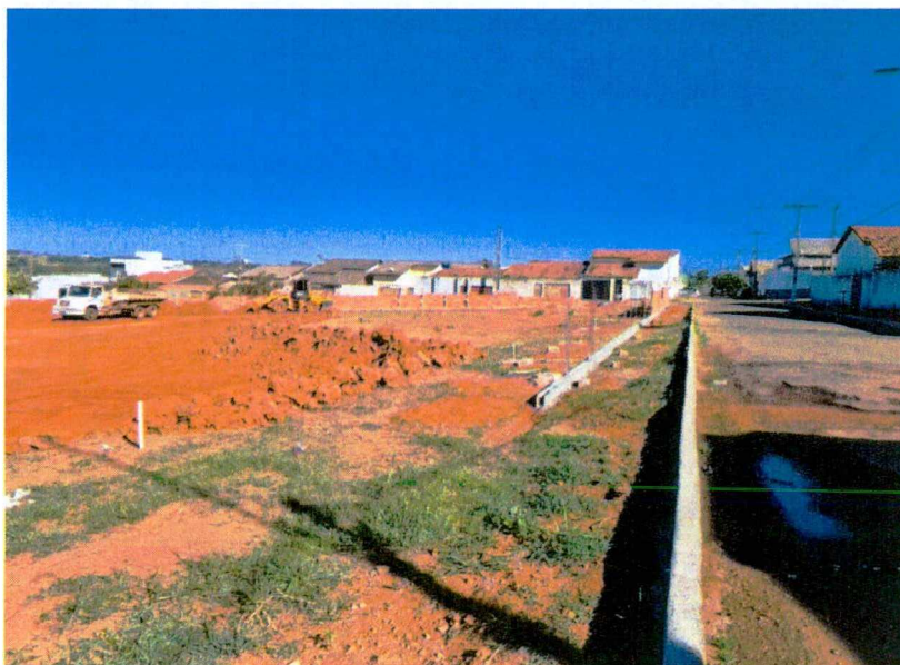
Foto 03: Execução de viga baldrame do muro de fechamento
