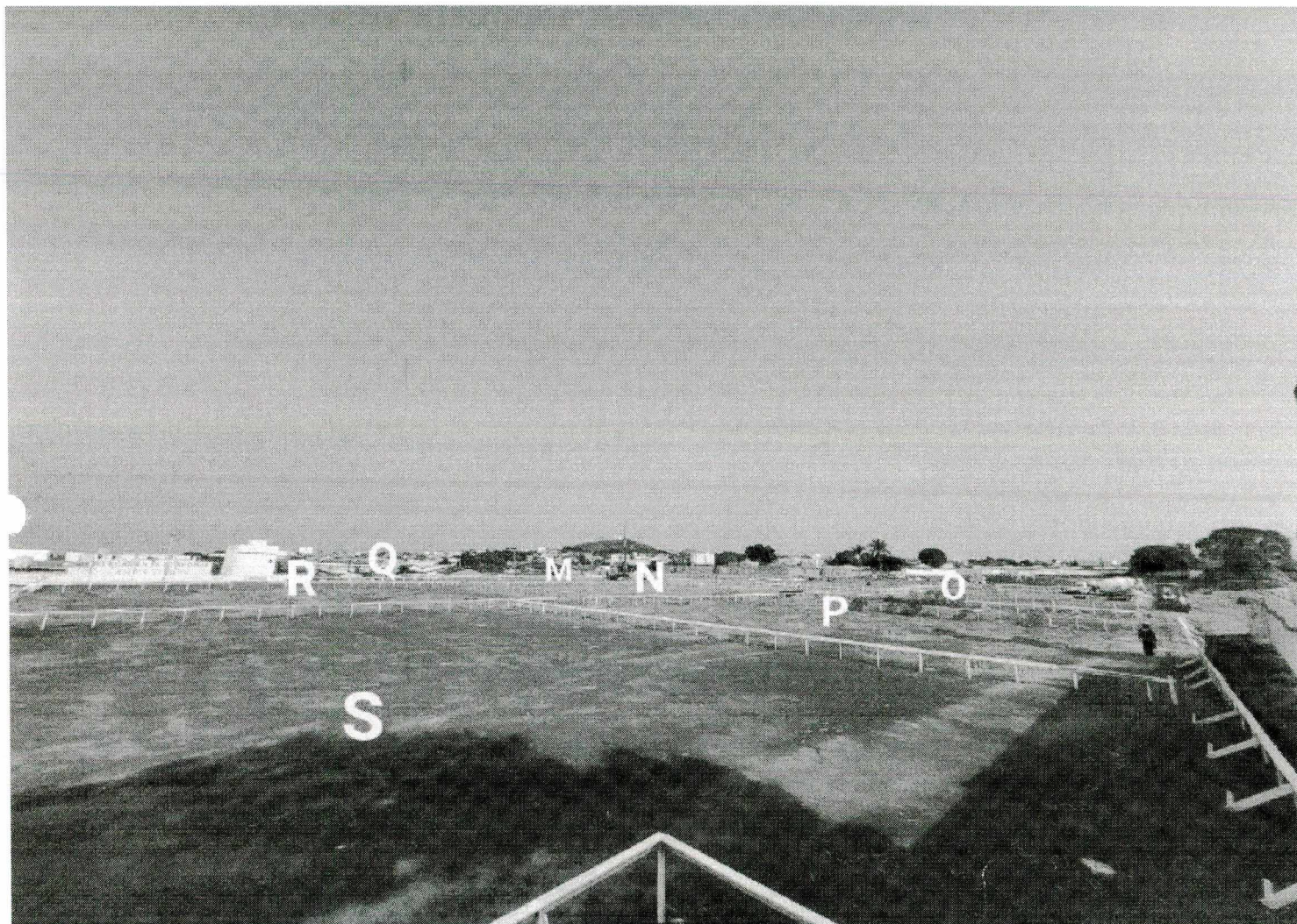
FOTO 9 – JUNTAS N, O, P, R: Estacas perfuradas. Juntas: M, Q, S: Aguardando perfuração.
