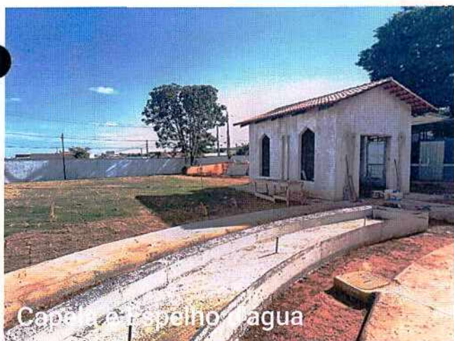
Fotos 17 a 19: Concretagem do espelho d'água; execução da infra das instalações do espelho d' água; montagem das telhas da capela.
