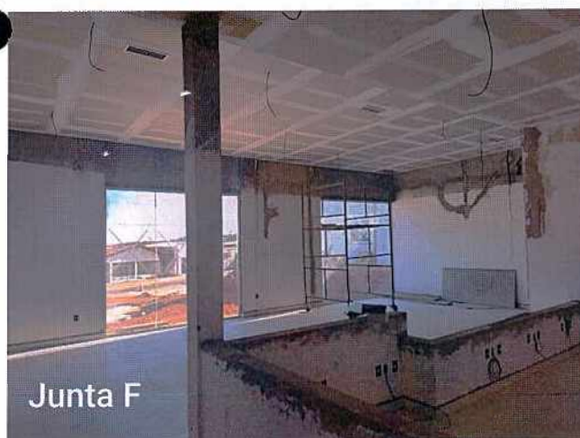
Fotos 11 e 12: Montagem do forro dos corredores; execução de instalações elétricas; instalação de portas;
