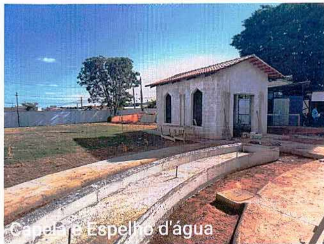
Fotos 17 a 19: Concretagem do espelho d'água; execução da infra das instalações do espelho d' água; montagem das telhas da capela.
