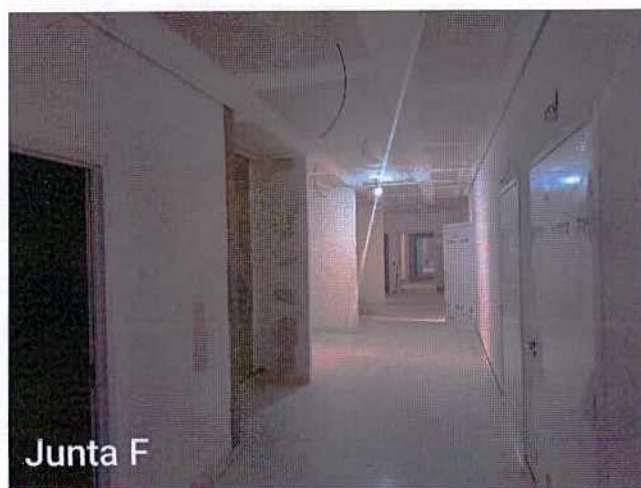
Fotos 11 e 12: Montagem do forro dos corredores; execução de instalações elétricas; instalação de portas;
