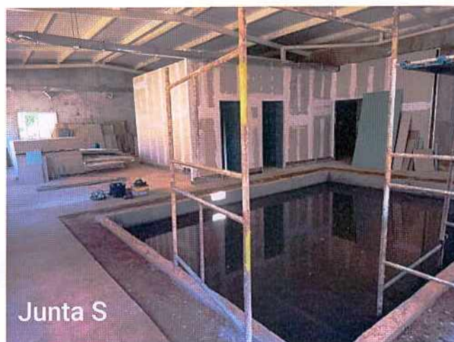
Fotos 21 e 22: Execução de revestimento cerâmico; montagem do forro; montagem do drywall; instalação de luminárias; execução das instalações da piscina;
