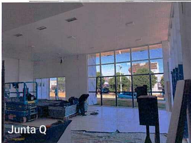
Fotos 19 e 20: Montagem de forro; instalação de luminárias; montagem da pele de vidro;
