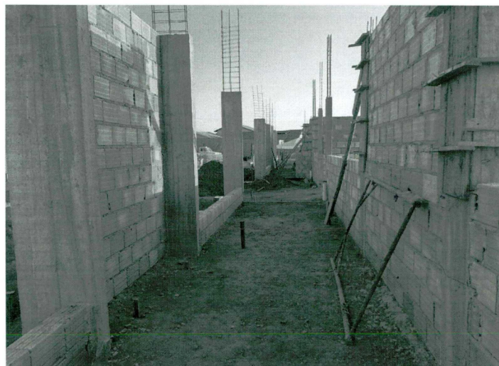
Foto 4: Execução de pilares da superestrutura.
