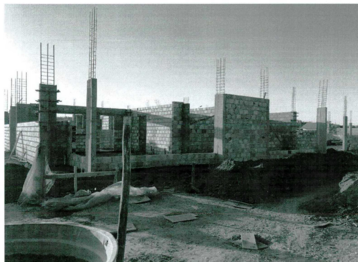
Foto 7: Execução de alvenaria, e execução de pilares.
