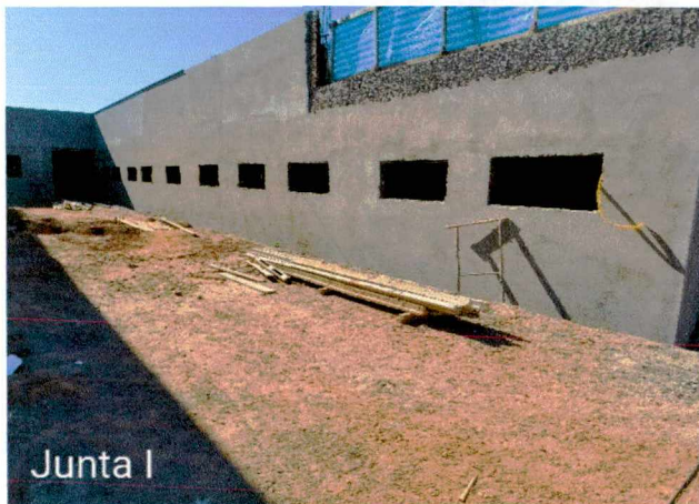
Fotos 30 a 33: Execução de reboco externo; regularização das calhas; concretagem do contrapiso (magro); regularização do contrapiso;
