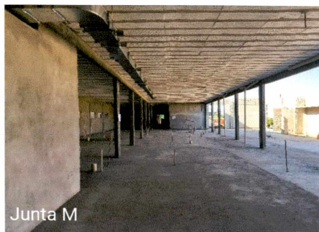
Foto 43 e 44: Execução de reboco interno e externo; concretagem do contrapiso (magro); execução de instalações (hidrossanitárias e infra dutos); regularização do contrapiso;
