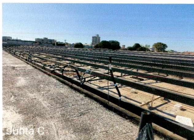
Fotos 5 a 7: Execução de impermeabilização das calhas; montagem da estrutura metálica; execução de instalações elétricas;
