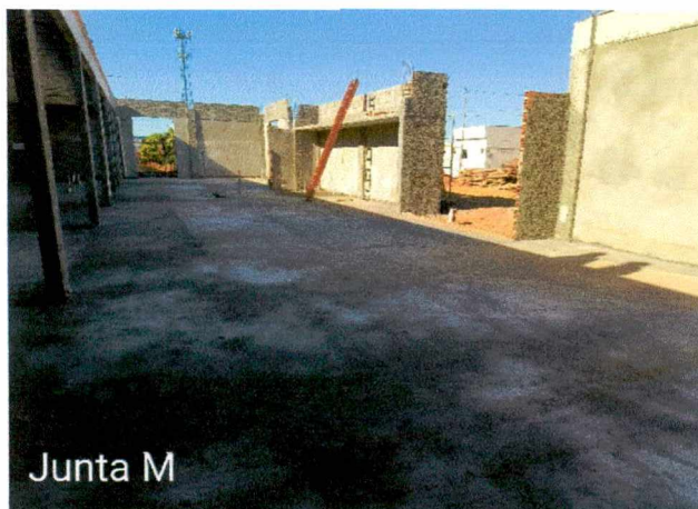
Foto 43 e 44: Execução de reboco interno e externo; concretagem do contrapiso (magro); execução de instalações (hidrossanitárias e infra dutos); regularização do contrapiso;
