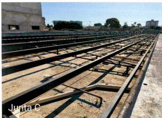
Fotos 5 a 7: Execução de impermeabilização das calhas; montagem da estrutura metálica; execução de instalações elétricas;
