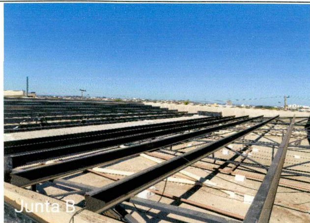
Fotos 5 a 7: Execução de impermeabilização das calhas; montagem da estrutura metálica; execução de instalações elétricas;
