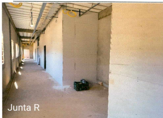
Fotos 55 e 56: Montagem do drywall; execução de alvenaria da platibanda;
