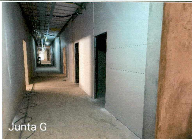
Fotos 25 a 27: Execução de instalações (hidrossanitárias, infra dutos e gases medicinais); regularização do contrapiso; montagem do drywall; montagem da estrutura metálica;
