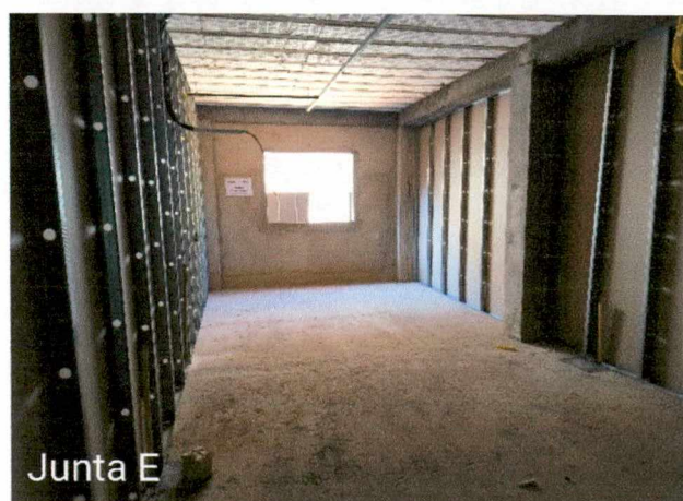
Fotos 18 a 20: Montagem do drywall; montagem da estrutura metálica; execução de impermeabilização das calhas;
