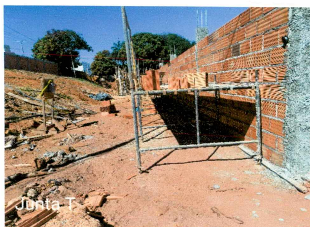
Foto 57: Concretagem de blocos, baldrame, pilares, vergas e contravergas; execução de alvenaria.
