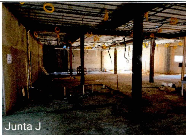
Fotos 34 a 36: Concretagem do contrapiso (magro); regularização do contrapiso; execução de instalações (elétricas e hidrossanitárias);
