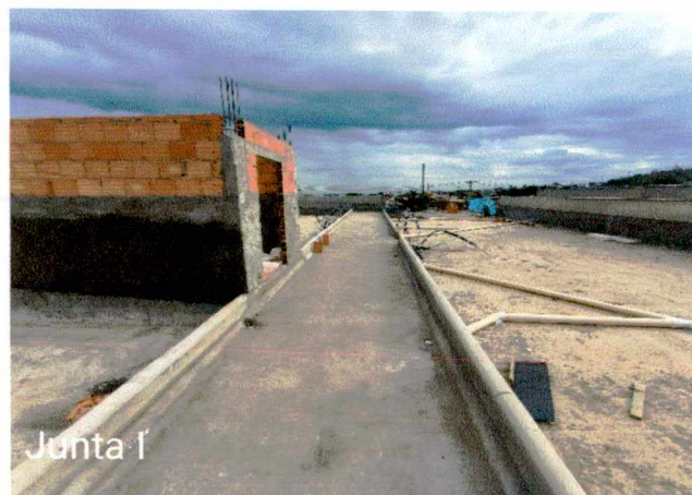
Fotos 30 a 33: Execução de reboco externo; regularização das calhas; concretagem do contrapiso (magro); regularização do contrapiso;
