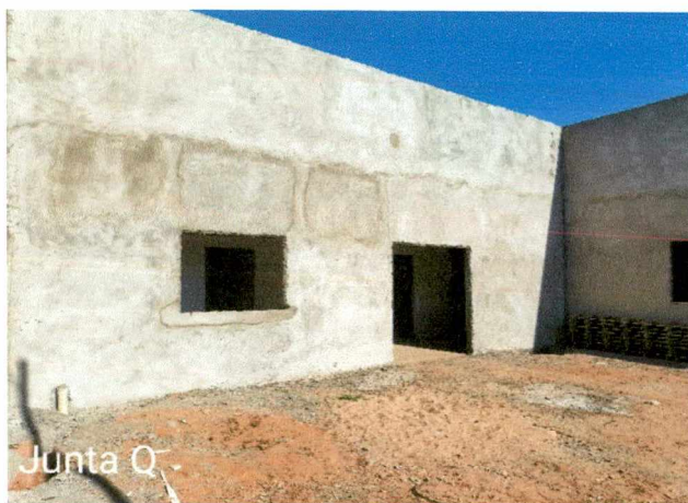
Fotos 49 a 51: Execução de instalações hidrossanitárias; execução de chapisco e reboco interno e externo; concretagem do contrapiso (magro);
