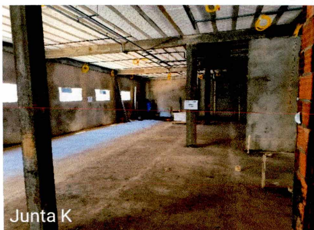
Fotos 34 a 36: Concretagem do contrapiso (magro); regularização do contrapiso; execução de instalações (elétricas e hidrossanitárias);
