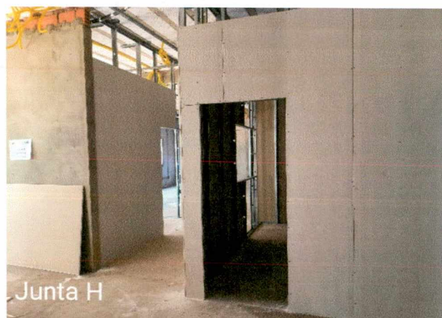
Fotos 25 a 27: Execução de instalações (hidrossanitárias, infra dutos e gases medicinais); regularização do contrapiso; montagem do drywall; montagem da estrutura metálica;
