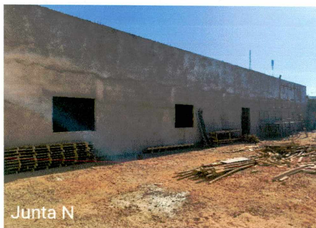
Fotos 45 a 48: Execução de alvenaria da platibanda; execução de chapisco interno e externo; execução de reboco interno e externo;
