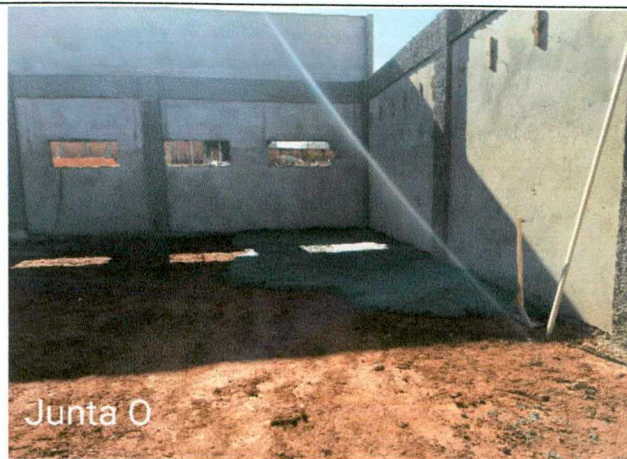
Fotos 49 a 51: Execução de instalações hidrossanitárias; execução de chapisco e reboco interno e externo; concretagem do contrapiso (magro);
