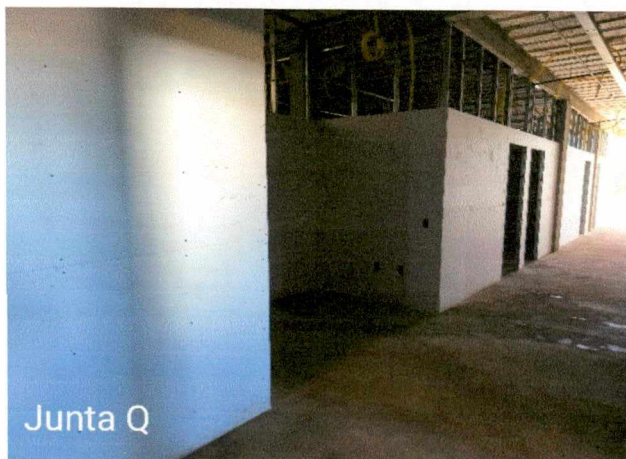
Fotos 52 e 54: Montagem do drywall; execução de instalações (infra dutos); execução de reboco externo;
