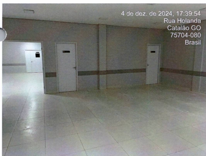
Fotos 14 a 17: Instalação de luminárias, execução de pintura, instalação de bate macas.
