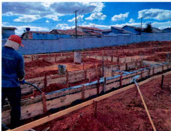
Foto 04: Execução de viga baldrame
