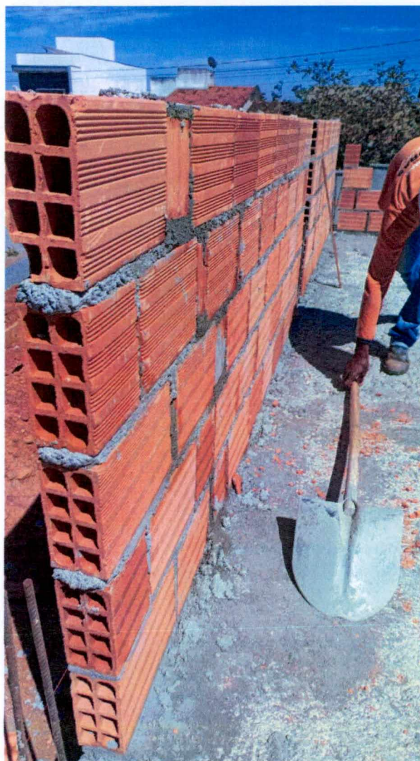
Foto 04: Levantamento de alvenaria
