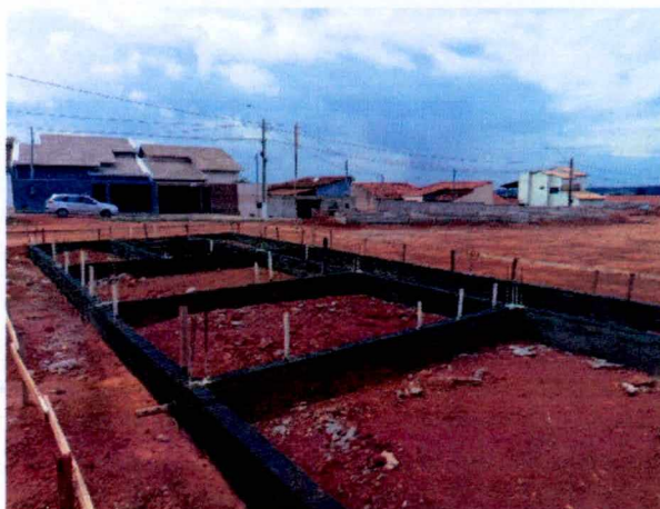
Foto 02: Impermeabilização de vigas baldrame
