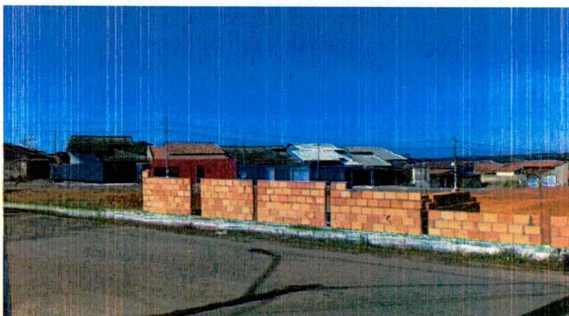
Foto 03: Alvenaria do muro de fechamento frontal
