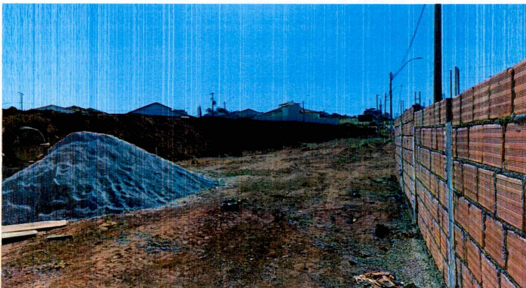
Foto 01: Alvenaria do muro de fechamento do fundo
