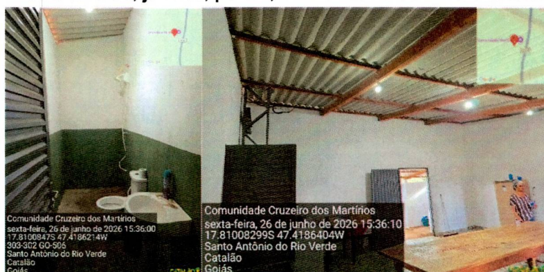
Figura 5: Reforma de telhado, janelas, portas, banheiros da cozinha e ambientes adjacentes
