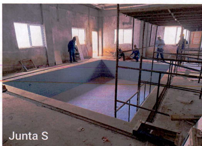
Fotos 19 a 20: Execução de revestimento cerâmico da piscina e do espelho d'água.
