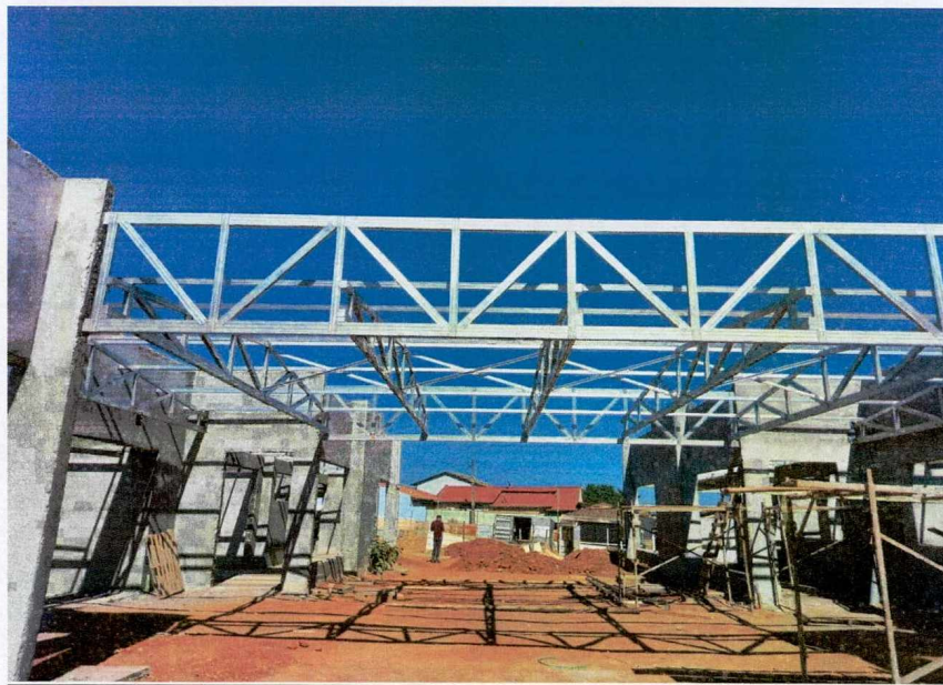
Foto 2: Execução da cobertura em steel frame.
