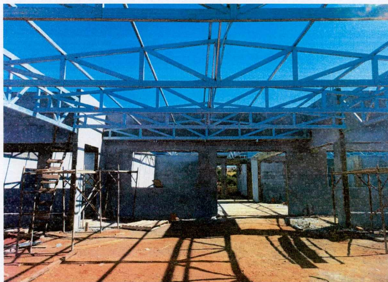
Foto 1: Execução da cobertura em steel frame.
