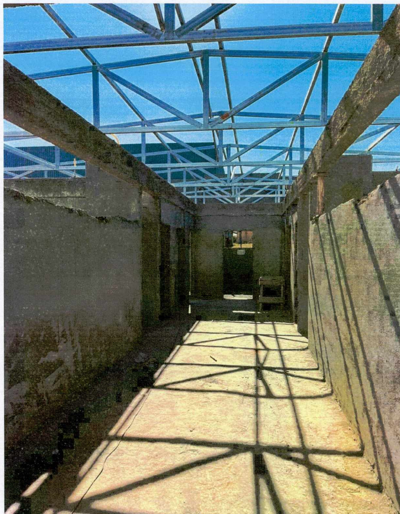
Foto 3: Execução da cobertura em steel frame.
