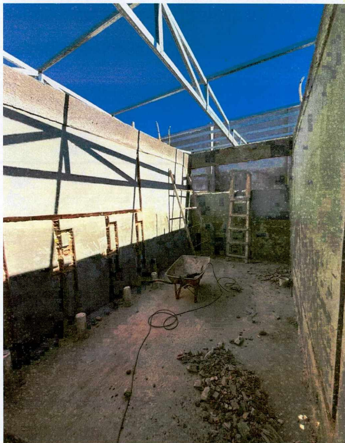
Fotos 4 e 5: Rasgos na alvenaria para a execução do sistema de instalações.
