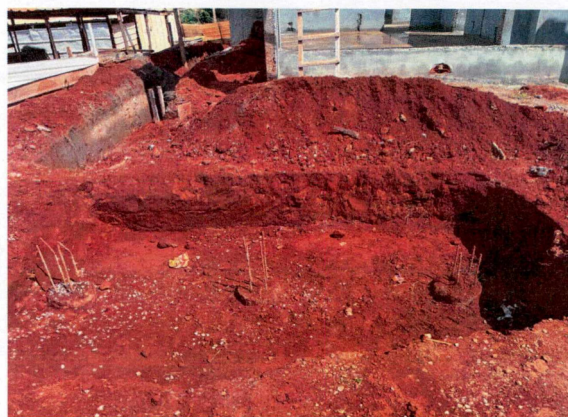
Foto 3: Estacas da fundação do Reservatório de água
