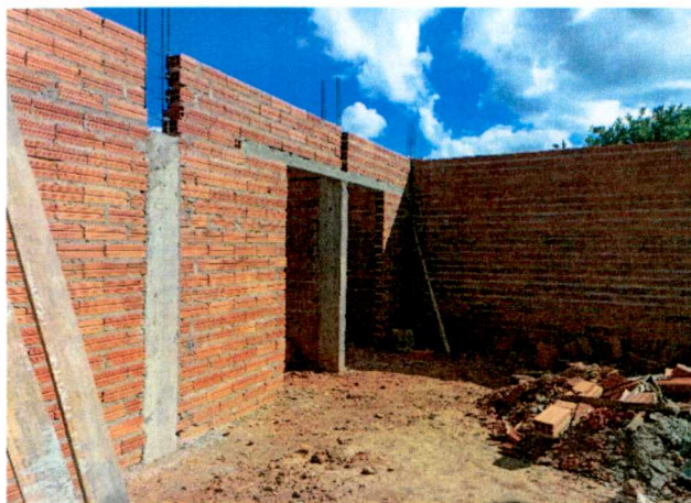
Foto 04: Concretagem de pilares, vergas e contraverga
