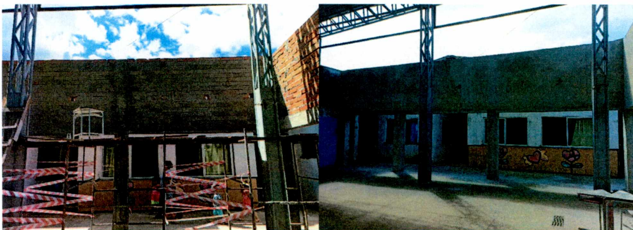
Foto 02: Chapisco, Emboço e Reboco da Platibanda dos Corredores
