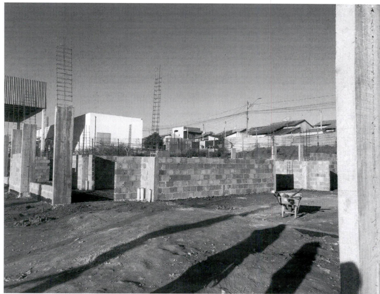
Foto 1: Execução de alvenaria
