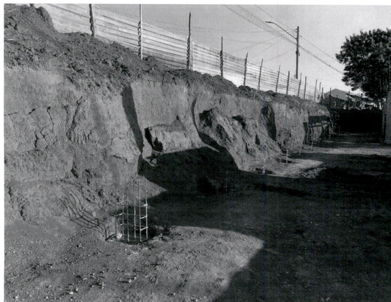
Foto 4: Concretagem fundação do muro
