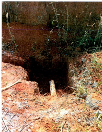
Foto 2: Caixa de passagem de esgoto
