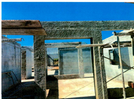
Foto 3: Chapisco das vigas aéreas da recepção
