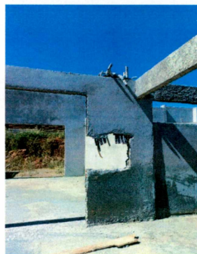
Foto 5: Abertura de encontro das fiações
